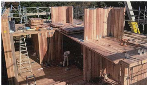
実験棟の建て方状況
