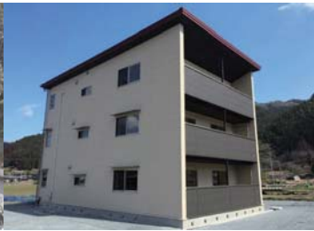
市営CLT春日住宅
