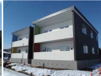
湯川村共同住宅
