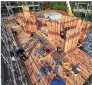
床版にU字型金物を設置し、下階の同金物にボルトで緊結して壁パネルを設置。
