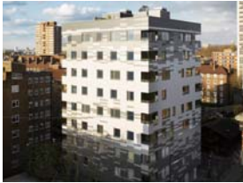
Stadthaus 9階建て分譲マンション。床・壁・エレベーターシャフトにCLTが使われています。(イギリス, 2009)
