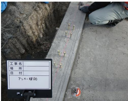
コンクリートスラブ・土間コンクリート・ならしモルタル等の基礎天端の仕上材を打設する前に、アンカーボルト頂部の位置誤差が許容差内であることを確認する。
