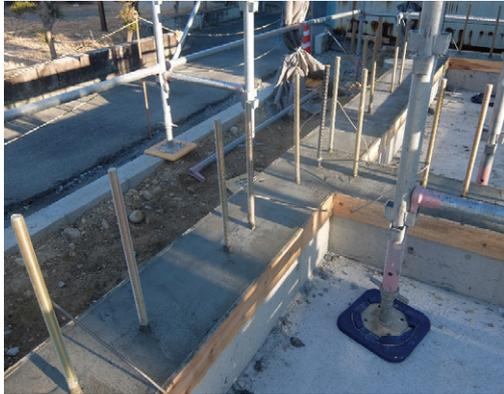
基礎コンクリート打設終了後、調整治具がコンクリートスラブ上に突出する場合、コンクリートスラブ打設前に撤去する。
