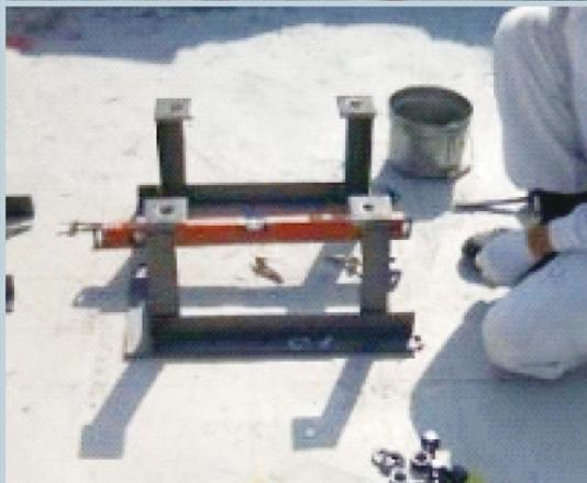
アンカーフレームが水平に据え付けられていることを確認し、固定する。
