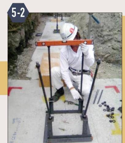
5-2 アンカーボルト設置・レベル調整
