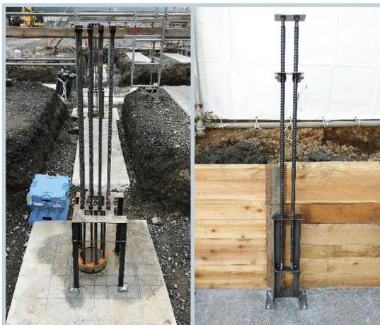
レベル調整終了後、ナット締めを行い、アンカーフレームに固定する。
