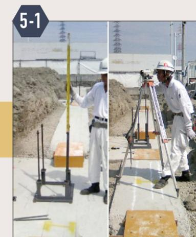
5-1 アンカーボルト設置・レベル調整
