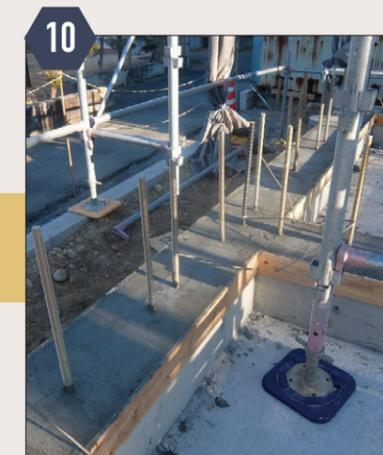
10 コンクリート打設完了・調整治具取り外し
