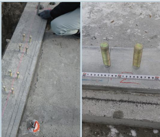
コンクリートスラブ・土間コンクリート・ならしモルタル等の基礎天端の仕上材を打設する前に、アンカーボルト頂部の位置誤差が施工許容差内であることを確認する。
