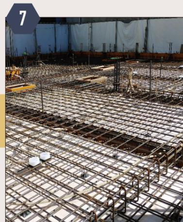
7 基礎配筋・型枠設置
