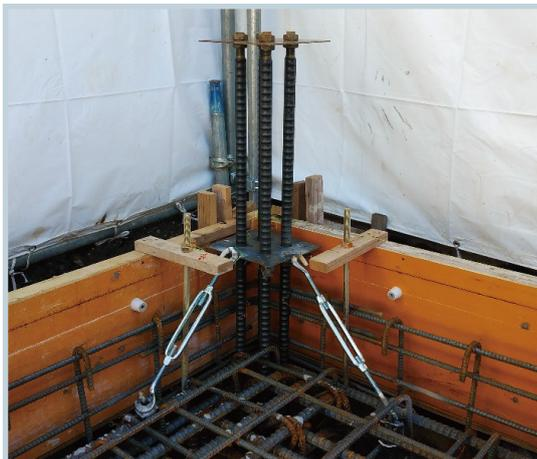
基礎配筋・基礎型枠終了後アンカーボルト位置を確認する。
