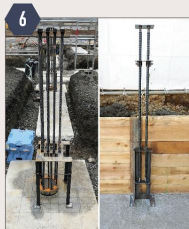
6 アンカーボルトの治具への固定
