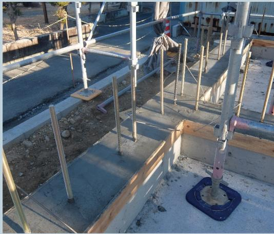
基礎コンクリート打設終了後、ターンバックルなどの調整治具がコンクリートスラブ上に突出する場合、コンクリートスラブ打設前に撤去する。
