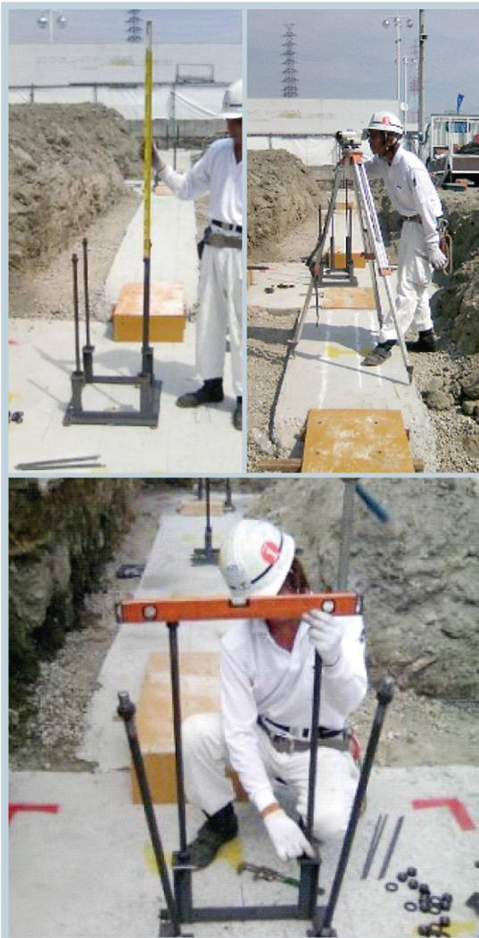
アンカーボルト頂部のレベルを確認する。
