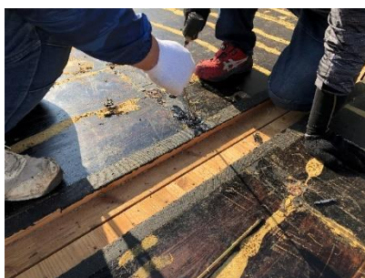
「CLT PARK HARUMI」解体時のビスの取り外し
