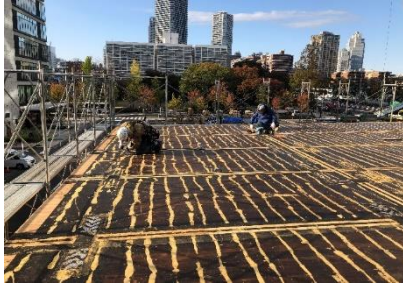
「CLT PARK HARUMI」解体時の CLT 防水処理の状況
