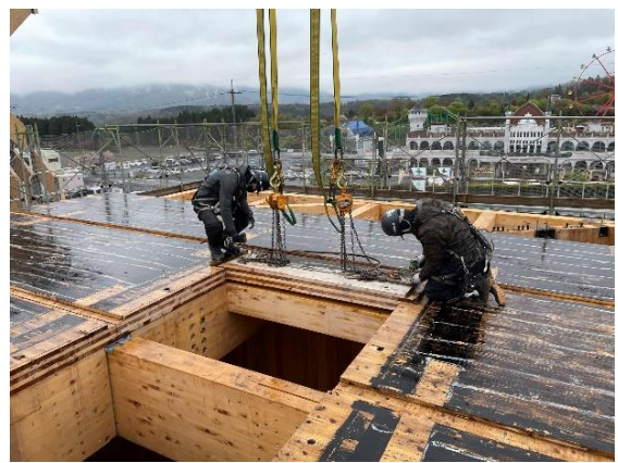
移設施工②
