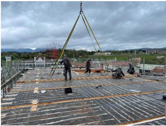
移設施工①
