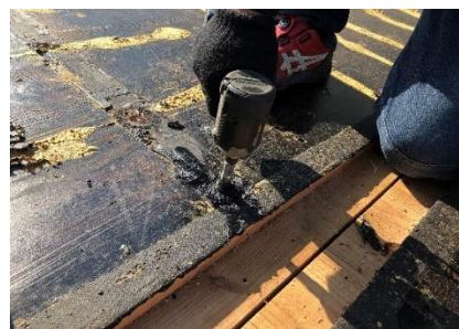
「CLT PARK HARUMI」解体時のビスの取り外し
