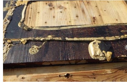
「CLT PARK HARUMI」解体時の CLT 防水処理の状況
