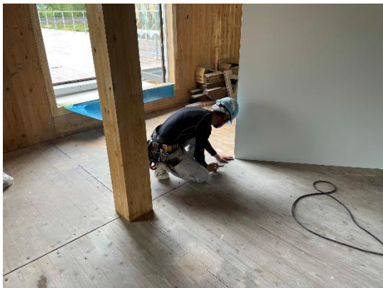
床版のすき間処理①
