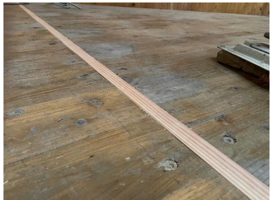
床版のすき間処理②
