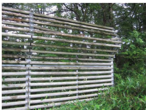
写真 5.2-3 木製防雪柵（福島県）
