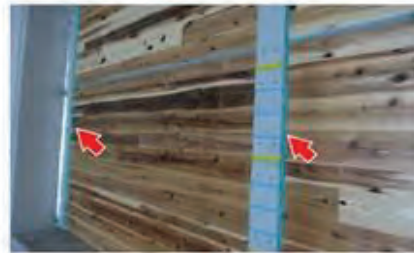
ケース2 支柱(H鋼)隙間のシール状況
