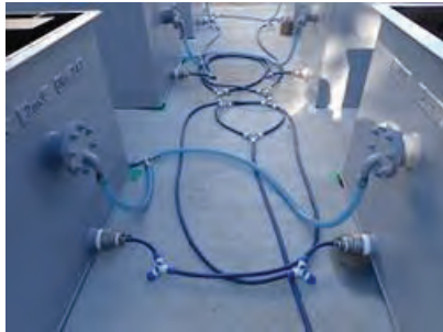
写真 4.11-5 給排水ホース経路
