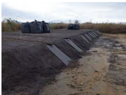
(x) 雨水排水対策，盛土完成状況
