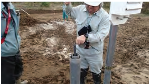
(h) 水位計の投入状況
