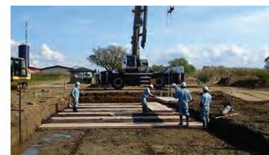
写真 1.2-1 CLT の敷設状況
