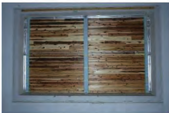
ケース 2 音源室試験状況
