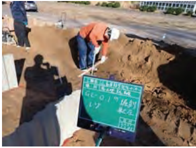
写真 4.9-16 キュービック供試体 GL-0.1m (かぶり厚)
