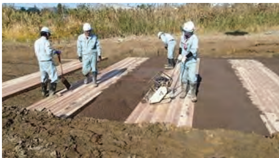
(l) CLT 間砂層の締固め状況
