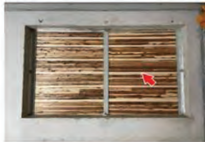
ケース3 積み重ね部分のシール状況
