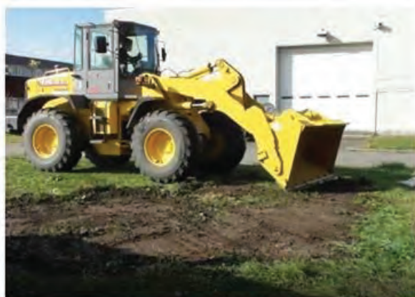
CLT敷板設置場所の整地作業
