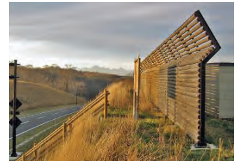
写真 1.3-2 木製防雪柵 (別海町)
