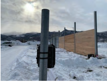
写真 1.3-9 定点カメラ設置状況
