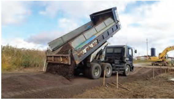
(q) 盛土の造成状況 (CASE1 部)
