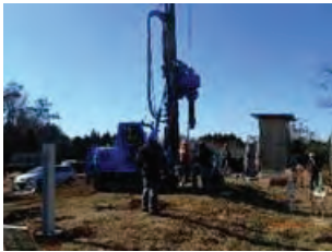
鋼管杭打設
