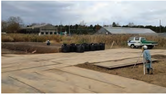
(u) 測量杭計測状況
