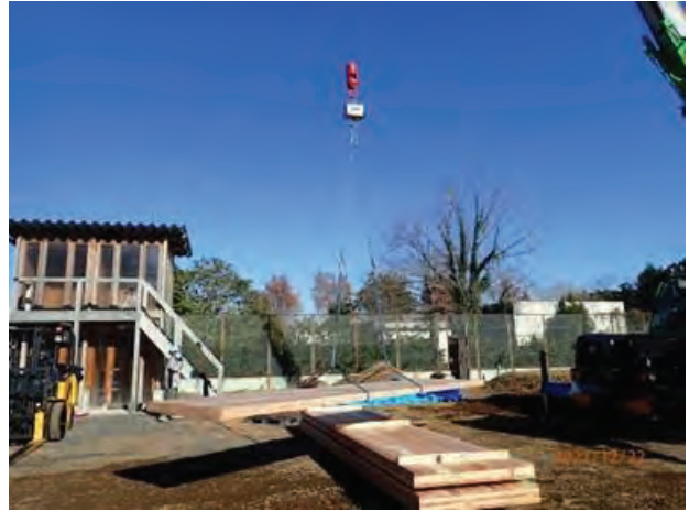
敷板の吊り下げと重量測定
