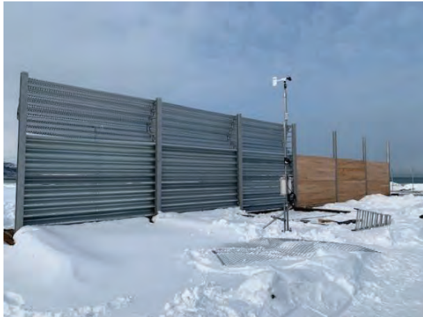
写真 5. 2-23 実験②定点観測機器（風下側） 設置状況
