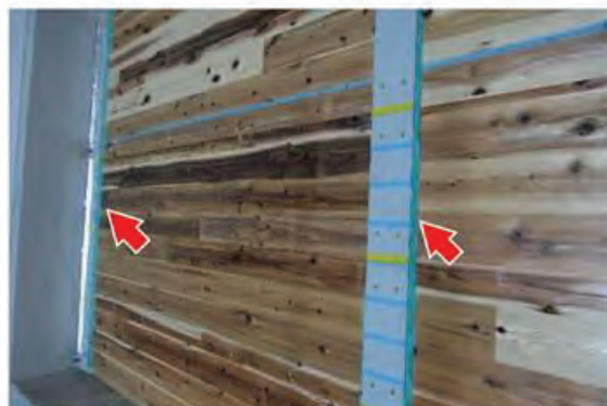
ケース 2 支柱(H 鋼)隙間のシール状況
