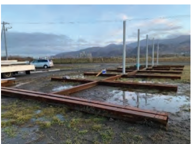
写真 1.3-6 架台、支柱設置状況
