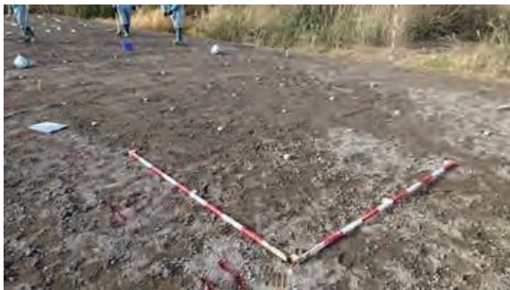
(s) 盛土上測量杭設置状況
