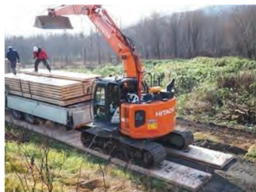
写真 5.3-14 CLT 敷板の敷設作業
