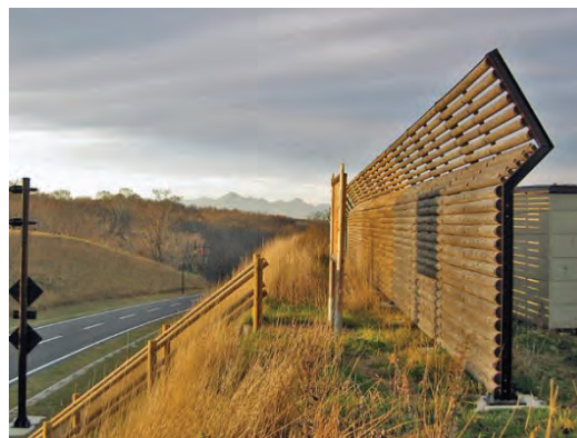
写真 5.2-2 木製防雪柵（別海町）
