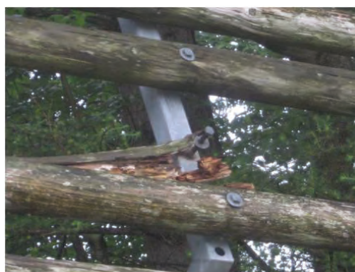
写真 5.2-4 木製防雪柵（福島県）
