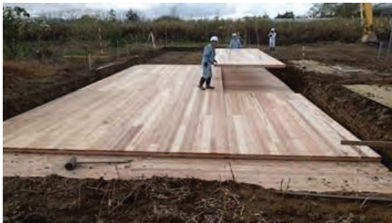
(r) 面状 CLT 2 段目敷設状況 (CASE3)
