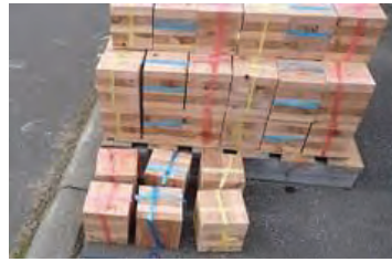
写真 4.7-2 キュービック平巻テープ取付状況
