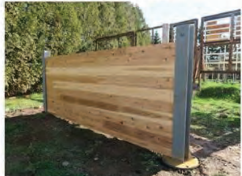
施工後のCLT防護柵
