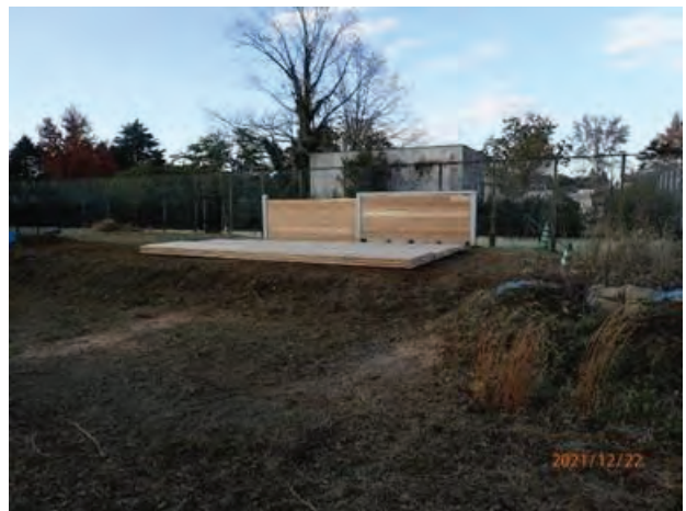
設置完了状況
