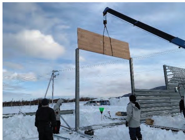
写真 5.2-18 CLT 防雪板設置状況
