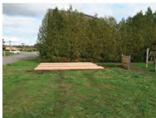
設置作業後のCLT敷板
