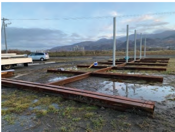
写真 5.2-17 架台、主柱設置
