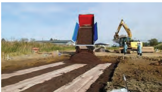
(p) 盛土材料の投入状況
