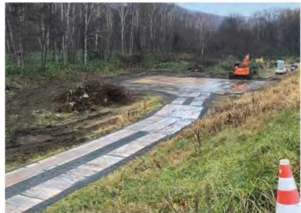
写真 1.4-2 CLT 敷板現場実証試験概要 (左：敷板仮設図、右：仮設状況全景)
