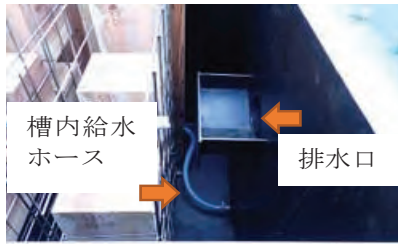
給水出口は排水口反対側にホース配置
