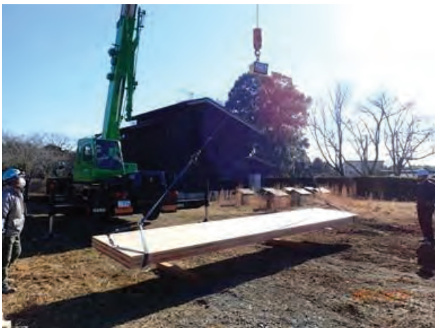
敷板の仮接地
