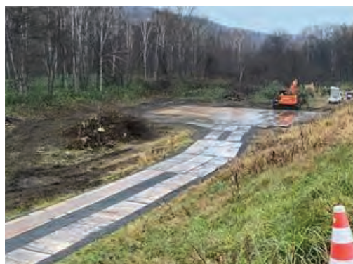
写真 5.3-18 敷設後の CLT 敷板 (全景)
