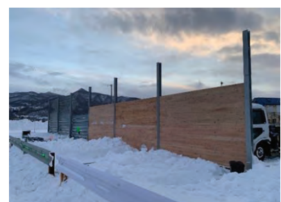
写真 1.3-8 CLT 防雪板設置完了
