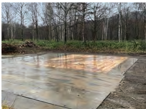
写真 5.3-17 敷設後の CLT 敷板 (積込ヤード)
