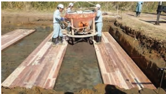
(k) CLT 間への砂の投入状況
