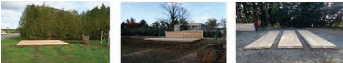
写真 1.4-1 CLT 敷板の設置状況(左・旭川市、中：つくば市、右：熊本市)
