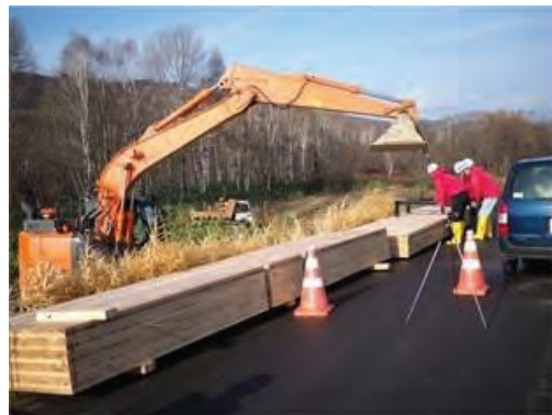
写真 5.3-12 CLT 敷板の荷下ろし作業
