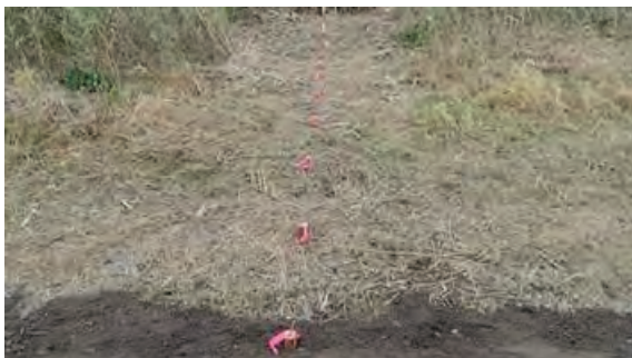
(t) 盛土周囲地盤測量杭設置状況
