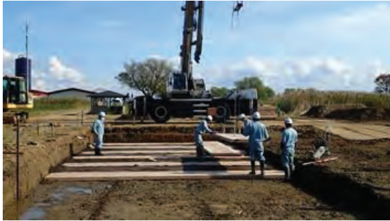
(m) 井桁状 2 段目の CLT 敷設状況
