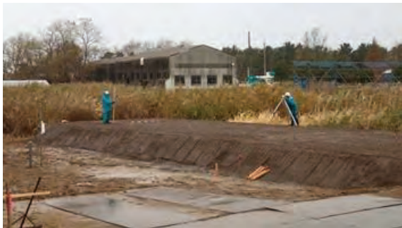
(v) 測量杭レベル計測状況
