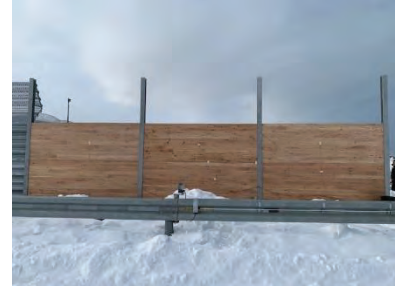
写真 1.3-11 熱電対設置状況
