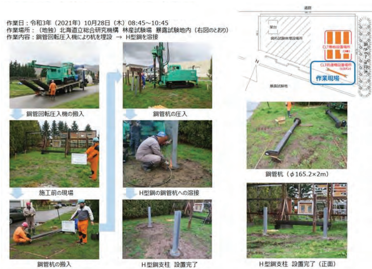
図 5.4-1 CLT 防護柵支柱 (H 形鋼) の施工 (旭川市)
