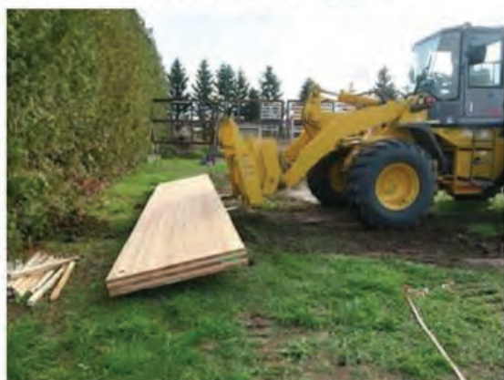
CLT敷板の設置作業
