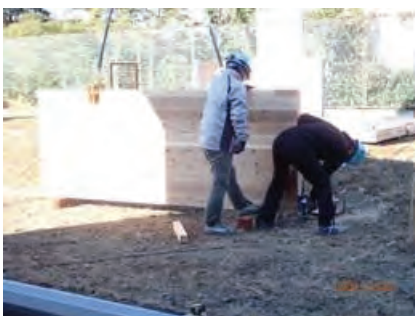
CLT 端部の加工
