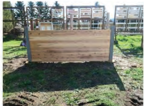
施工後のCLT防護柵
