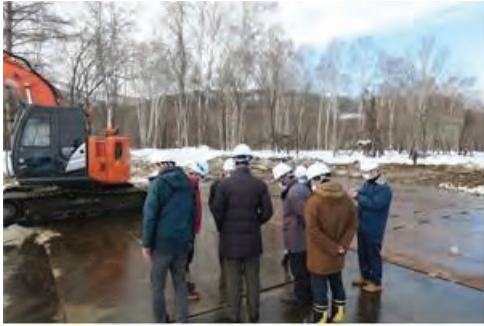
写真 5.3-25 CLT 敷板実証試験現場の視察
