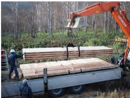
写真 5.3-11 CLT 敷板の荷下ろし作業
