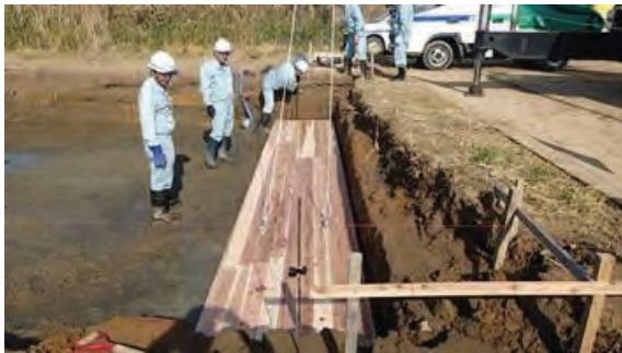
(j) 井桁状の CLT 敷設状況
