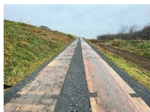
写真 5.3-16 敷設後の CLT 敷板 (取付運搬路)
