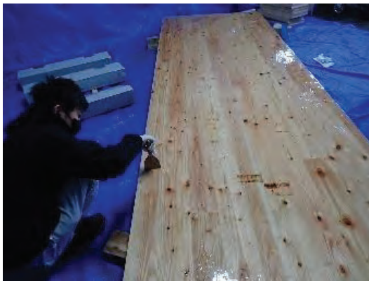
写真 5. 2-12 塗布作業 (防雪板)
