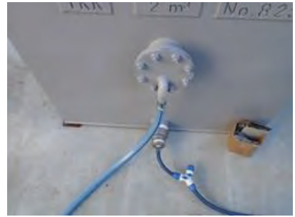
上：排水口 下：給水口
