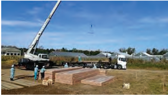
(i) CLT の搬入状況
