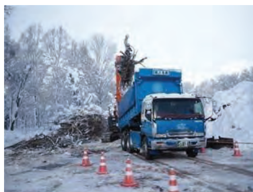
写真 5.3-22 積込ヤードでの作業の様子
