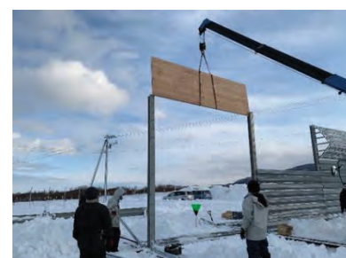
写真 1.3-7 CLT 防雪板設置状況
