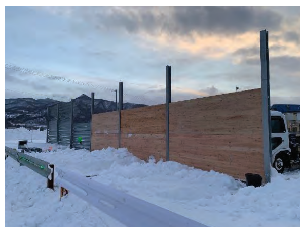
写真 5.2-20 CLT 防雪柵設置完了
