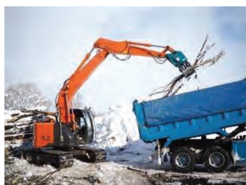
写真 5.3-21 積込ヤードでの作業の様子
