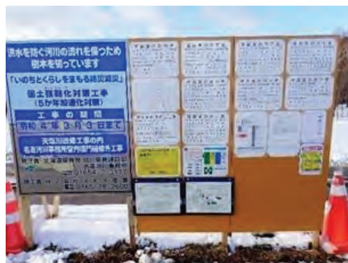
写真 5.3-24 CLT 敷板実証試験現場の 工事概要看板
