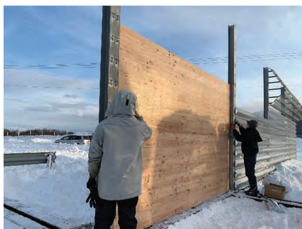
写真 5.2-19 CLT 防雪板設置状況
