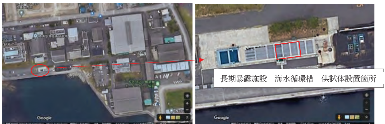
図 4.10-2 港湾空港技術研究所 長期暴露施設 (google マップより抜粋)
