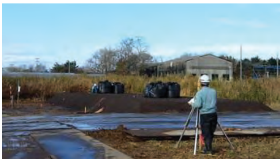
(w) トン袋載荷後測量杭計測状況
