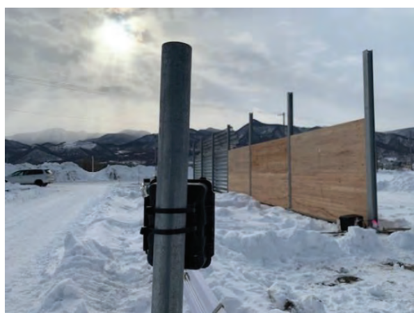
写真 5.2-21 実験①定点カメラ（風下側） 設置状況
