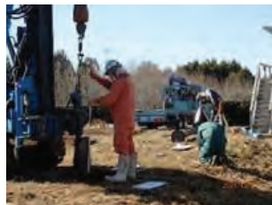
鋼管杭打設
