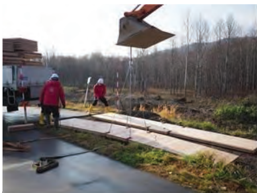
写真 5.3-13 CLT 敷板の敷設
