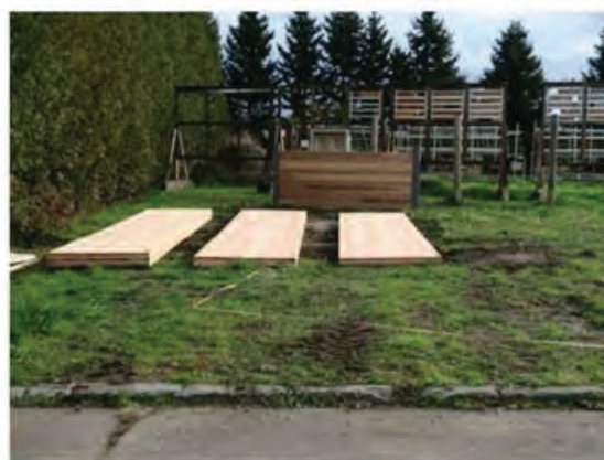
設置作業後のCLT敷板
