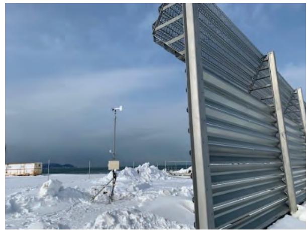
写真 5. 2-24 実験②定点観測機器（風上側） 設置状況
