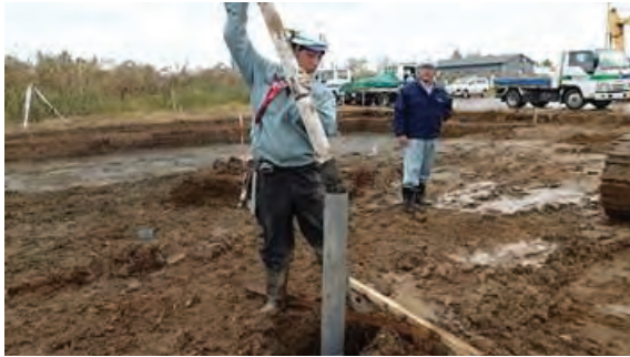
(e) 水位計観測井の設置状況
