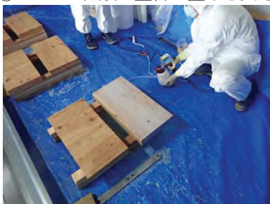
写真 1.3-3 撥水塗料の塗布
