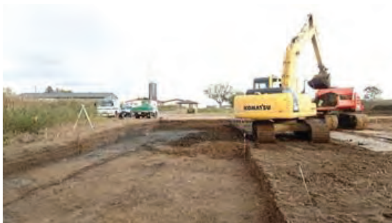
(b) 施工面までの地盤の掘削状況
