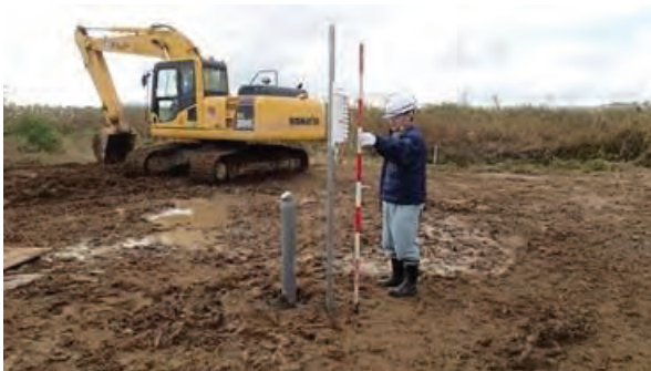
(f) 水位計観測井と百葉箱の設置状況
