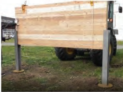
H型鋼支柱へのCLTの取り付け
