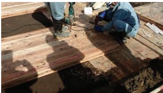
(o) 井桁状 CLT 孔開けとピン打ちの状況
