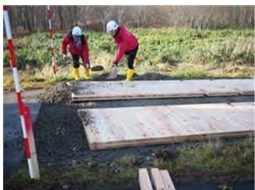
写真 5.3-15 段差解消のため採石の敷設
