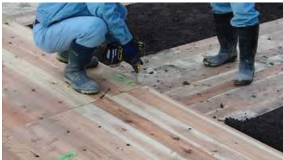
(n) 井桁状 CLT ラグスクリューによる仮固定状況
