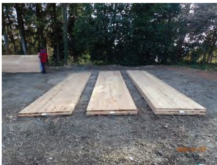
写真 5.3-3 CLT 敷板試験体の設置完了状況（熊本市）
