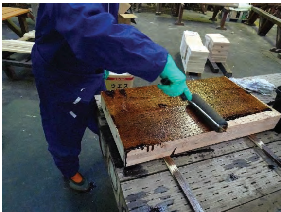
写真 1.7-1 クレオソート油による塗布処理
