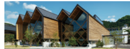
銘建工業本社事務所
