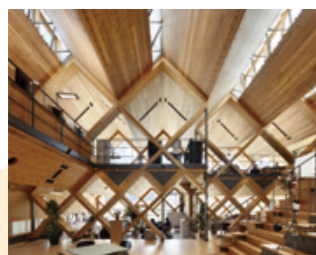
銘建工業本社事務所
