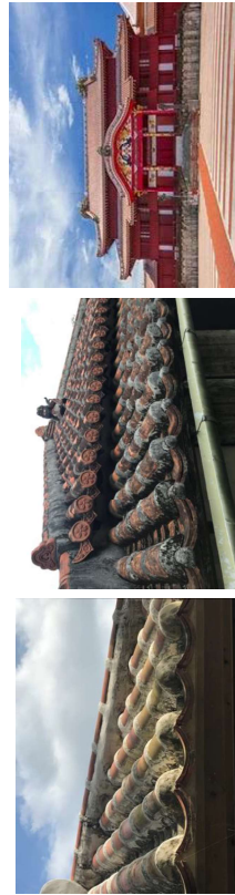
図13 (左) 中央経年経過した琉球赤瓦葺き屋根の状況 (右) 復元された首里城
