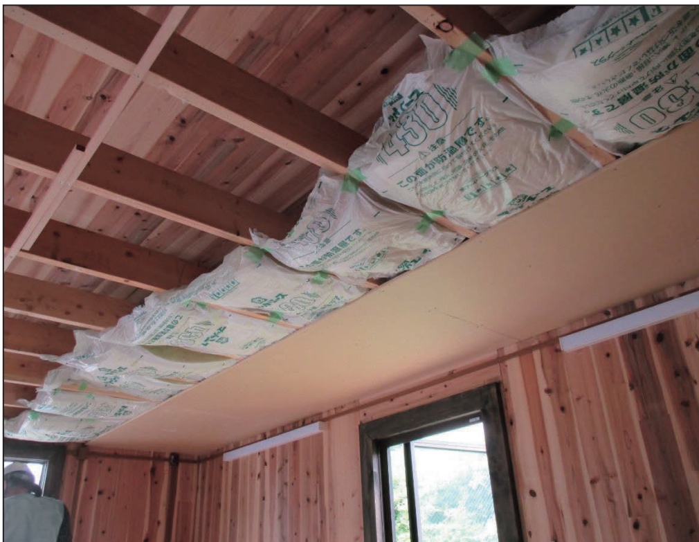
(2) 試験体 A2-1 (背後空気層 t465mm) の吸音材・せっこうボード (1層目)
