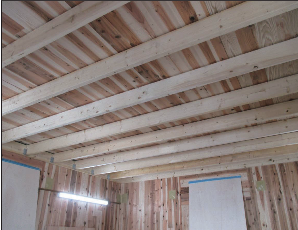
(1) 試験体 A1-1 (背後空気層 t150mm) の天井根太
