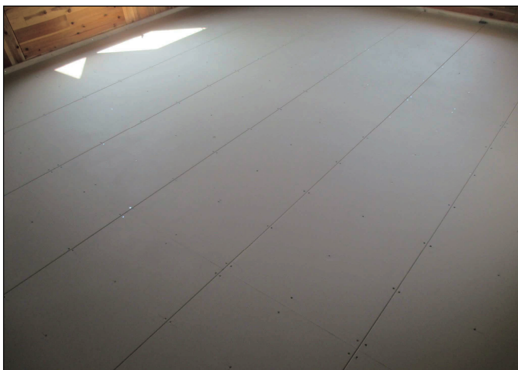
(f) 床上側：施工完了時（2時間耐火）
