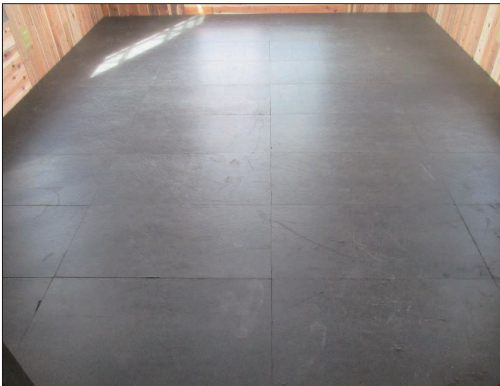
(2) アスファルト制振マット t8mm の施工
