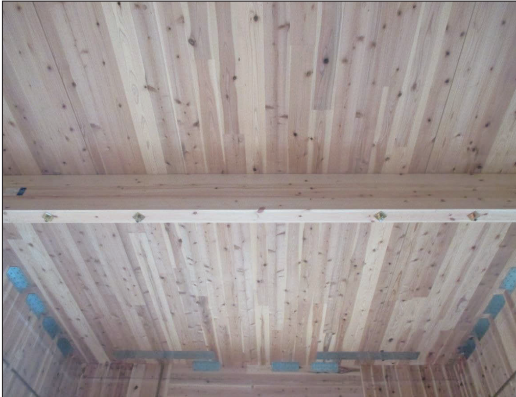
(1) 2階床の下部に梁材を取り付けた状況
