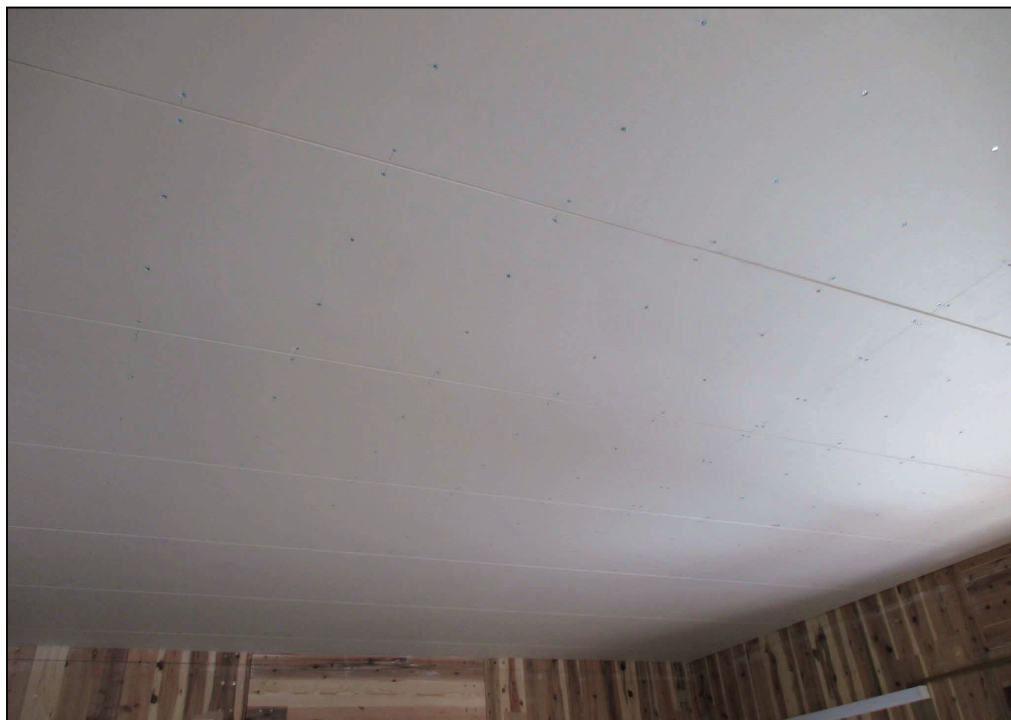
(g) 天井側：中張り強化石膏ボード（2時間耐火被覆）
