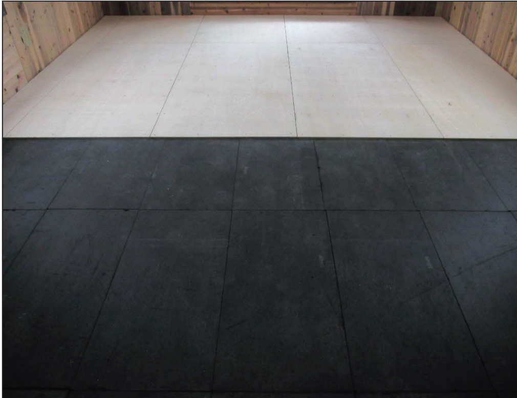
(1) 試験体 B1-2 : アスファルト制振マットと針葉樹合板 (捨張り) の施工
