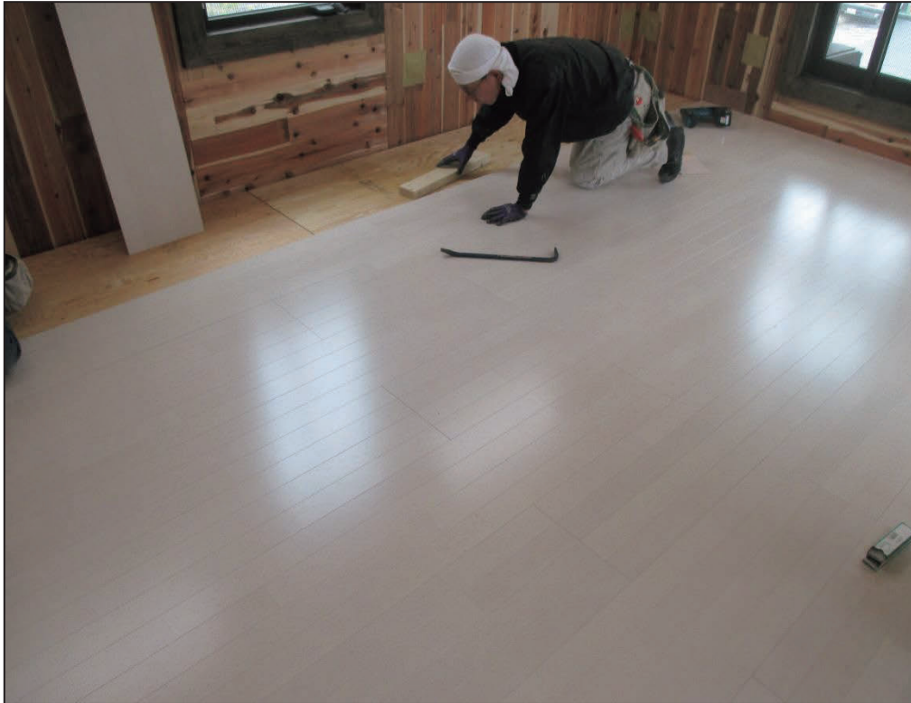
(1) 針葉樹合板(捨張り)の上にフローリングを施工
