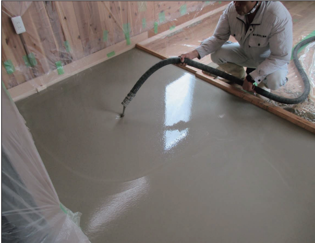
(1)セルフレベリング材の施工状況
