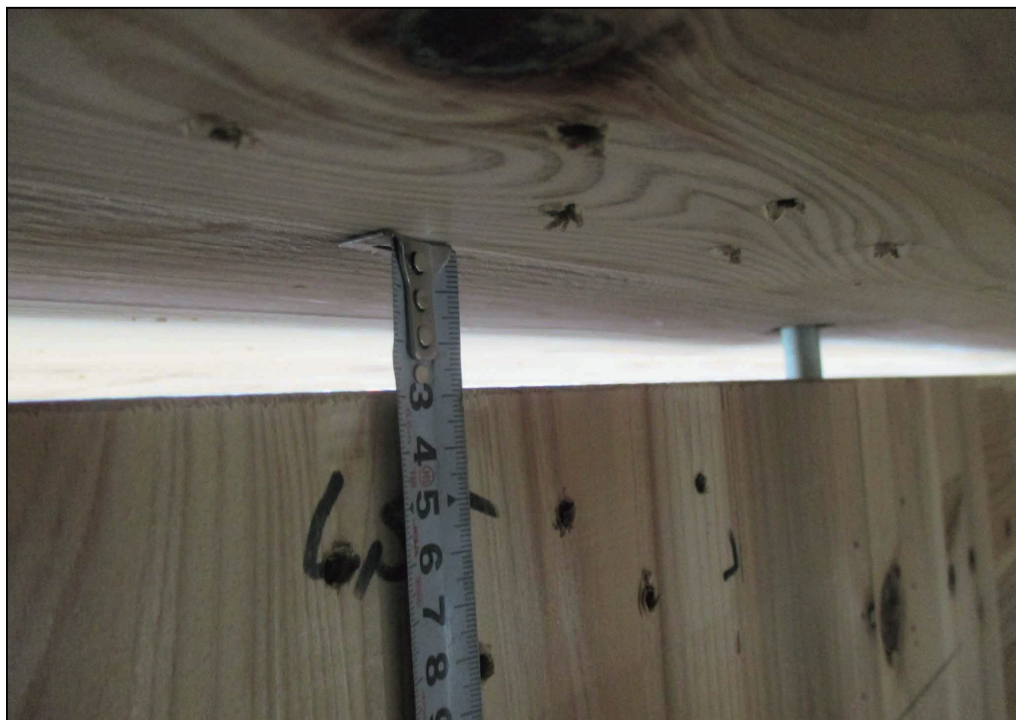
(b) 2階床パネルと1階壁パネルの縁切りの状況
