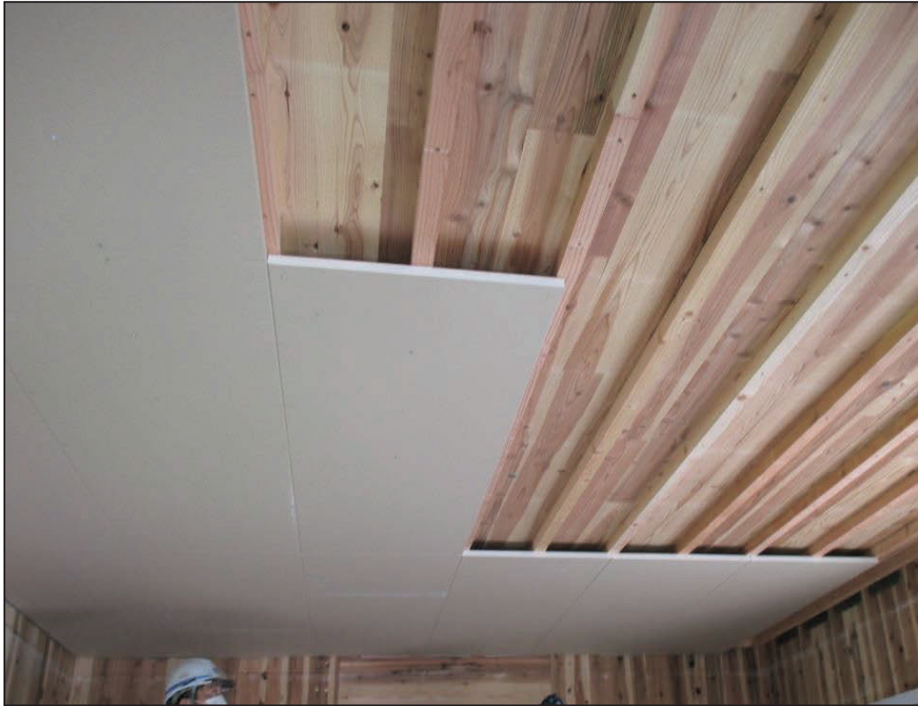
(1) 試験体 A3-2 : 1 階天井に根太・強化せっこうボード t21mm (1 層目) を施工
