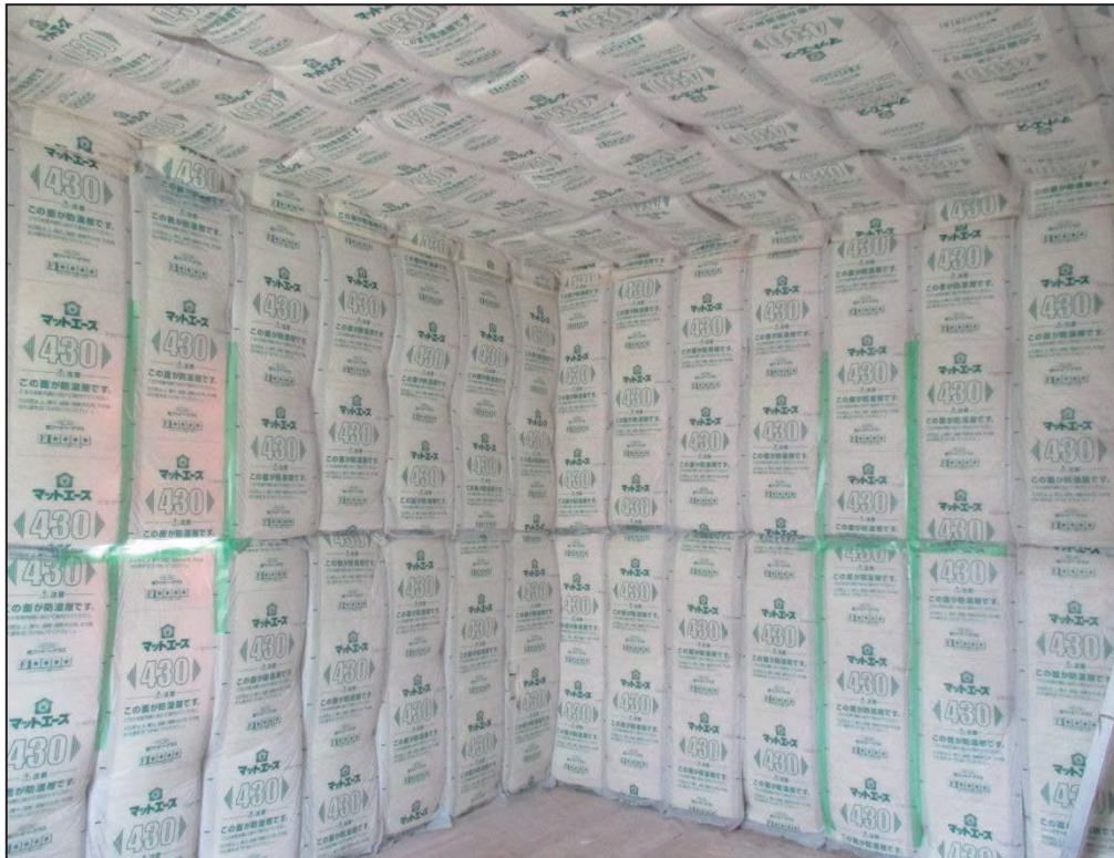
(1) インナールーム外周への吸音材の施工（天井面および壁面）
