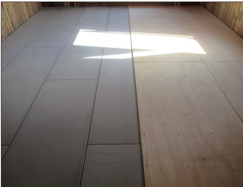
(2) 試験体 B1-3 : 繊維混入押出成形セメント板と針葉樹合板 (捨張り) の施工
