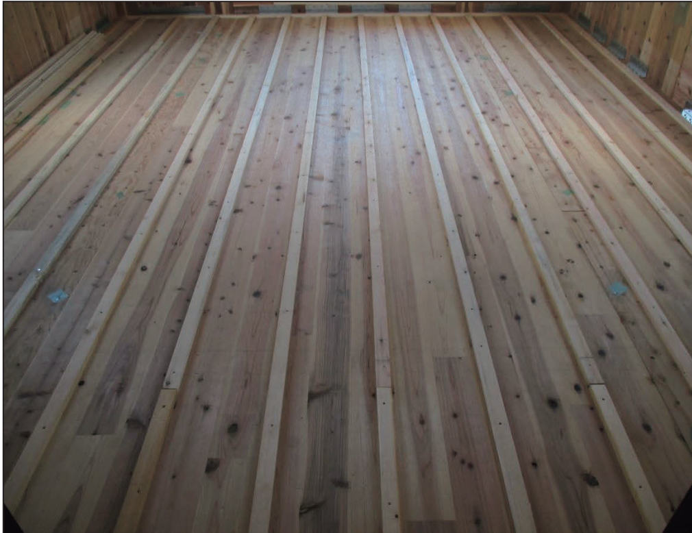
(1) 試験体 A3-1 : 2 階床上に根太 t18mm を施工
