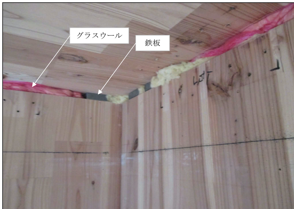
(e) グラスウールによる隙間塞ぎの状況
