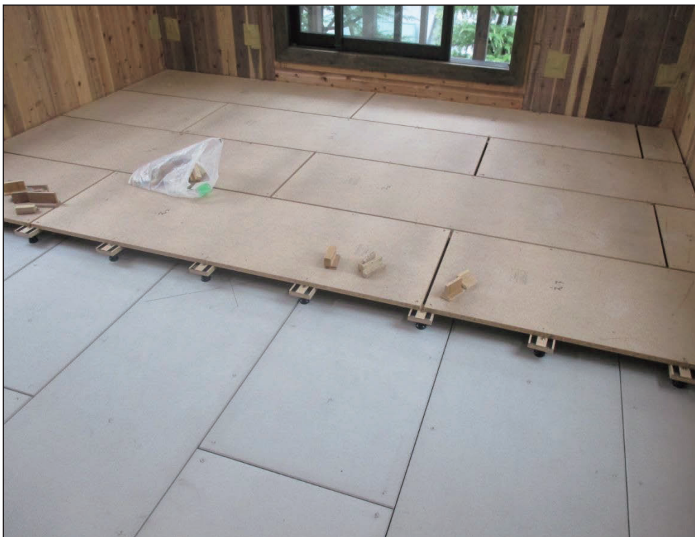
(2) 試験体 B1-2 : 下地（繊維混入押出成形セメント板）の上に乾式二重床の支持脚・下地パネルを施工
