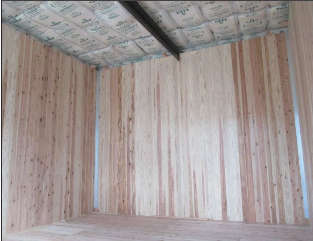
(1) 床パネルおよび壁パネルまで施工した状態（施工中）
