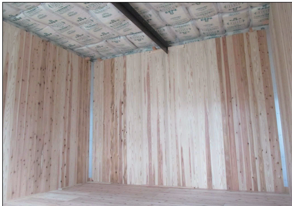
(f) 壁 J パネルおよびC T形鋼
