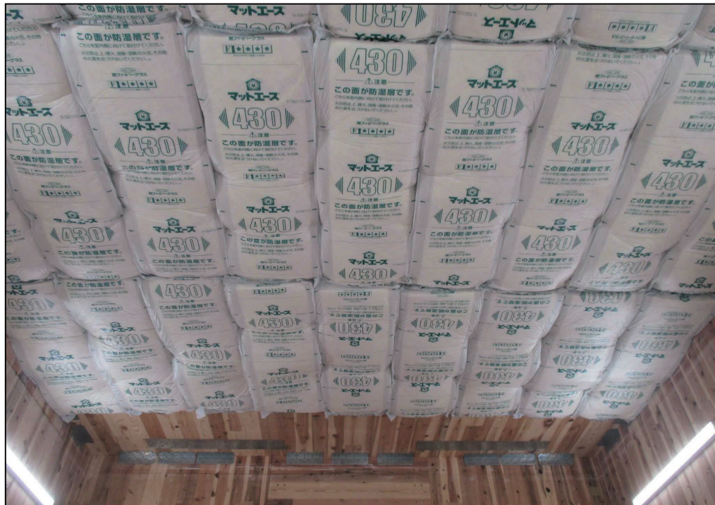
(a) 天井面グラスウール：施工途中
