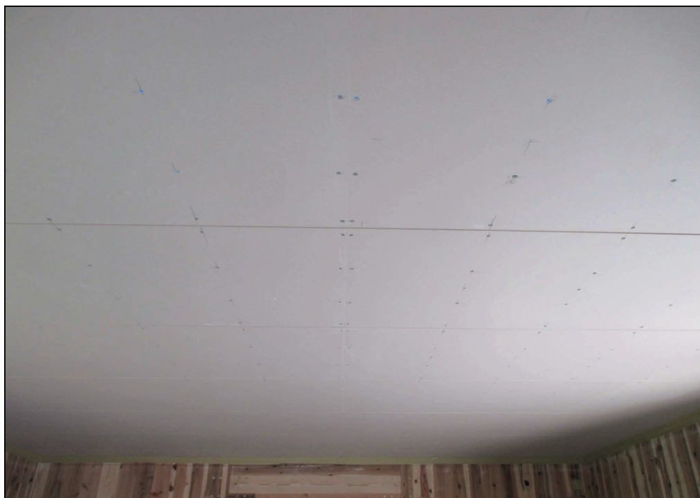
(e) 天井側：施工完了時（1時間耐火被覆）
