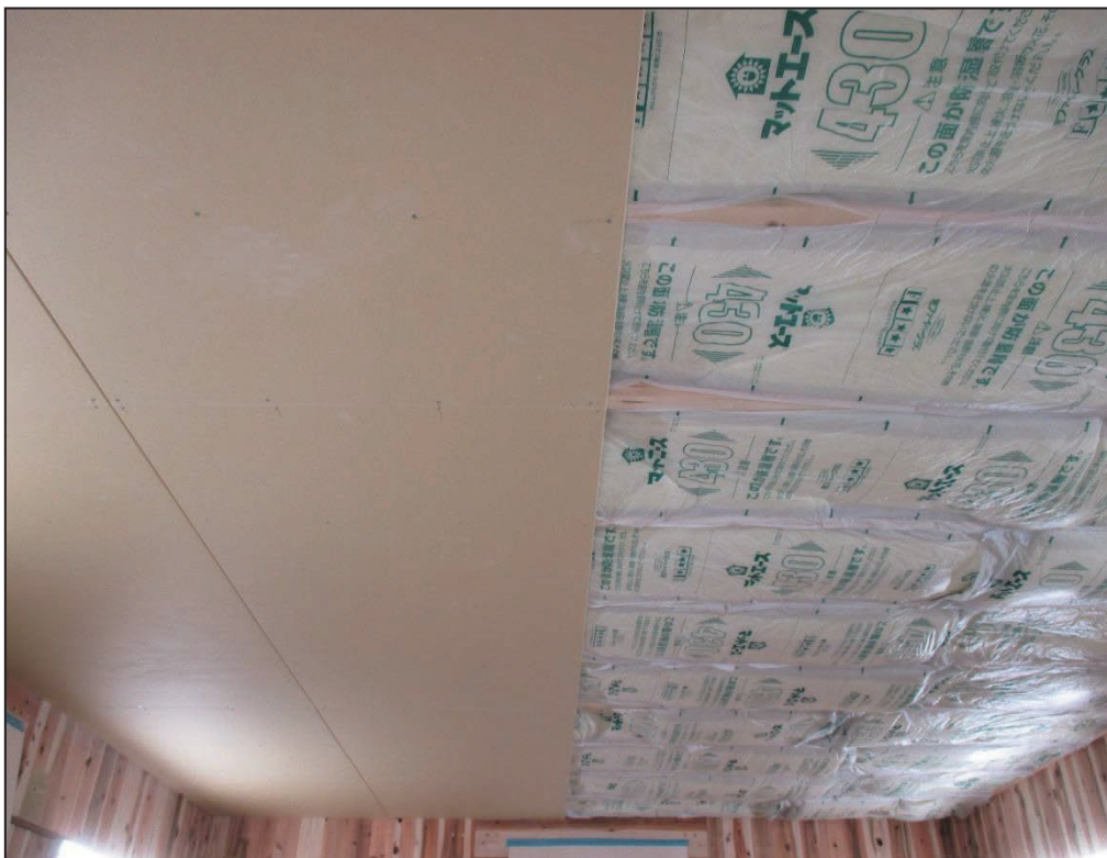
(2) 試験体 A1-1 (背後空気層 t150mm) の吸音材・せっこうボード (1層目)
