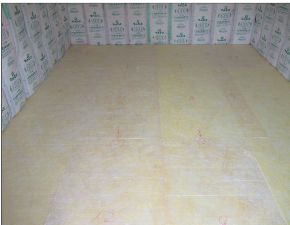
(2) インナールーム外周への吸音材の施工（床面および壁面）
