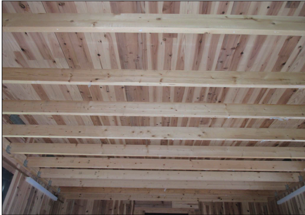
(a) 2 × 6 根太：空気層厚 465 mm
