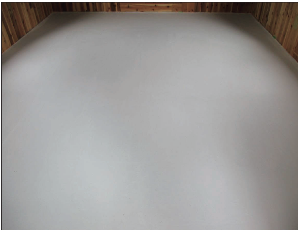
(2)セルフレベリング材の施工・養生後
