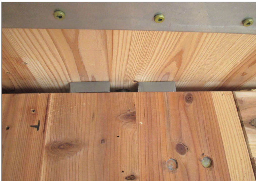
(d) 緊結ボルト付近の鉄板挟み込みの状況
