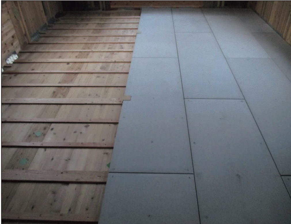
(1) 試験体 B1-1 : 根太 t12mm 上に繊維混入押出成形セメント板 t26mm を施工
