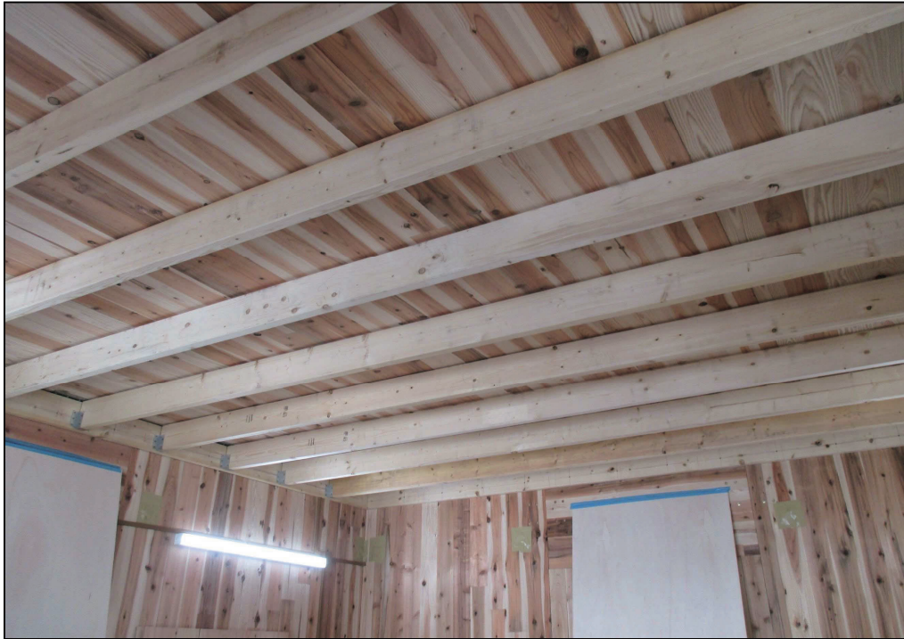
(a) 2×6 根太：空気層厚 150 mm
