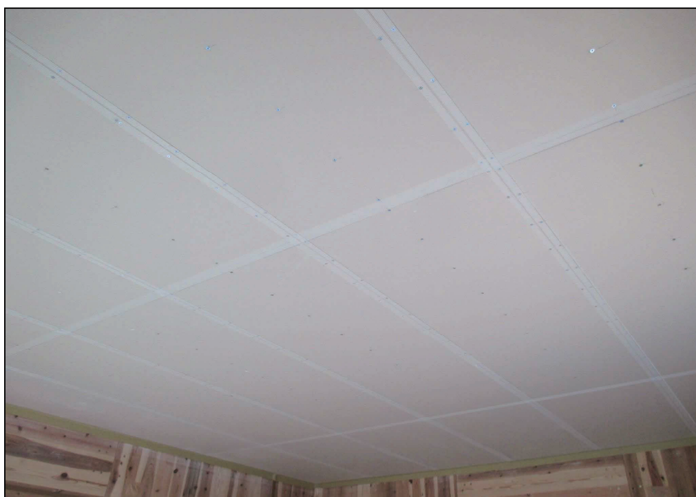
(h) 天井側：施工完了時（2時間耐火被覆）
