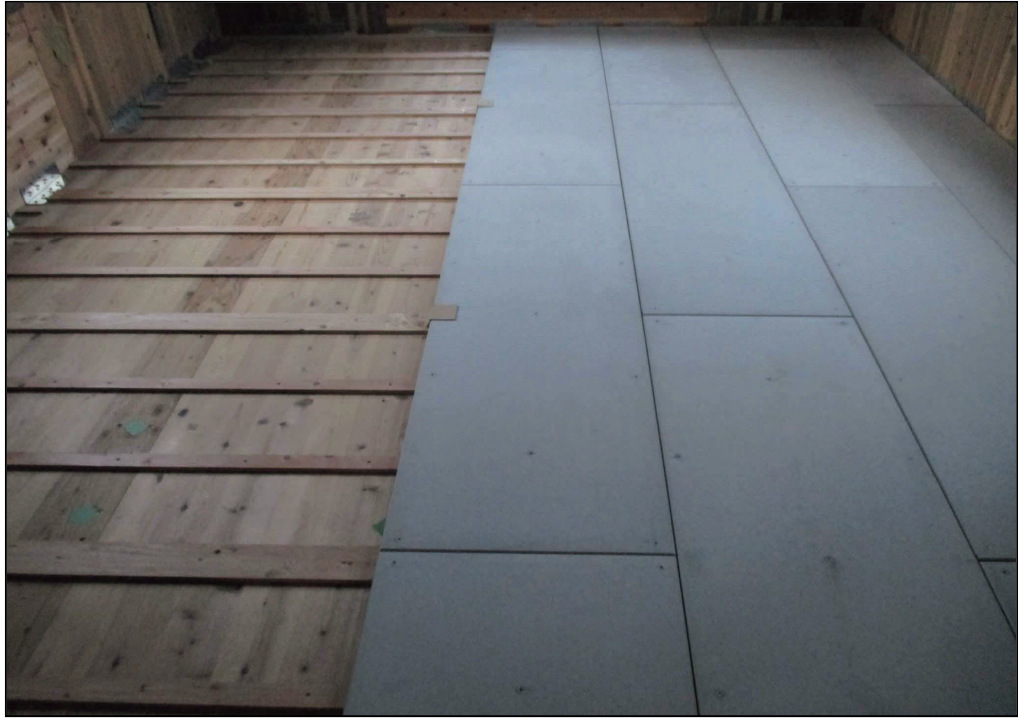
写真9 床根太・繊維混入押出成形セメント板の施工状況
