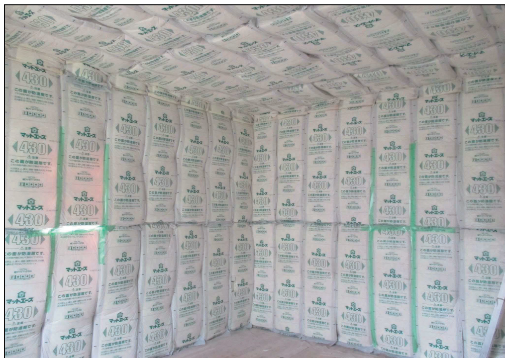
(b) 天井面および壁面のグラスウール
