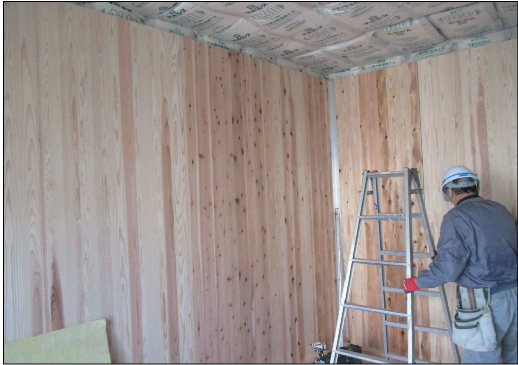
(e) 壁 J パネル：施工途中
