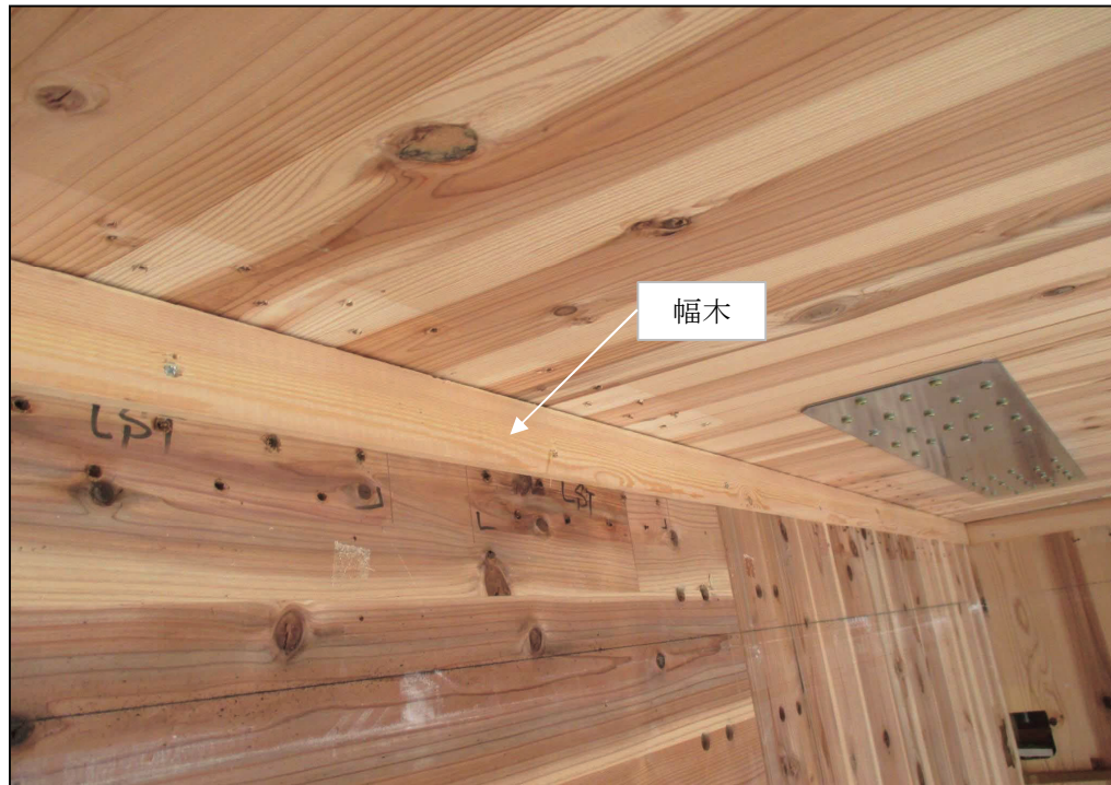
(c) 縁切り後の幅木による隙間塞ぎの状況
