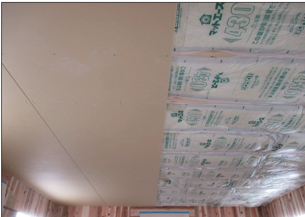
(b) 吸音材・下張り石膏ボード
