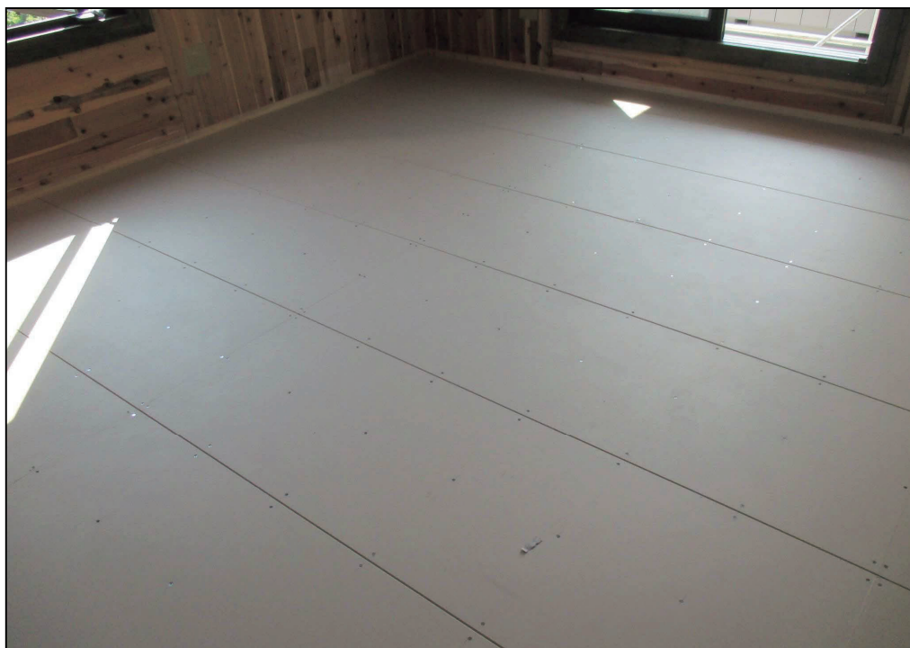
(c) 床上側：施工完了時（1時間耐火被覆）
