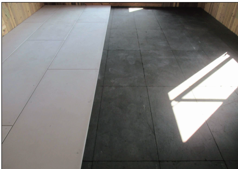
(h) 繊維混入押出成形セメント板（乾式二重床C）
