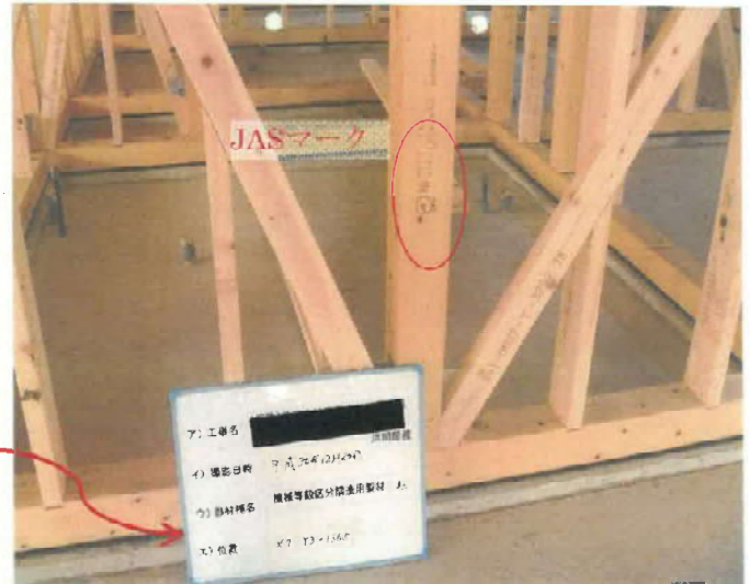
写真 施工写真の例
