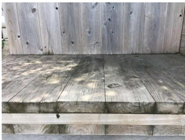
写真 14 : (設置場所:大阪／防腐処理材)水平面に生じたカビ、ラミナの干割れ
