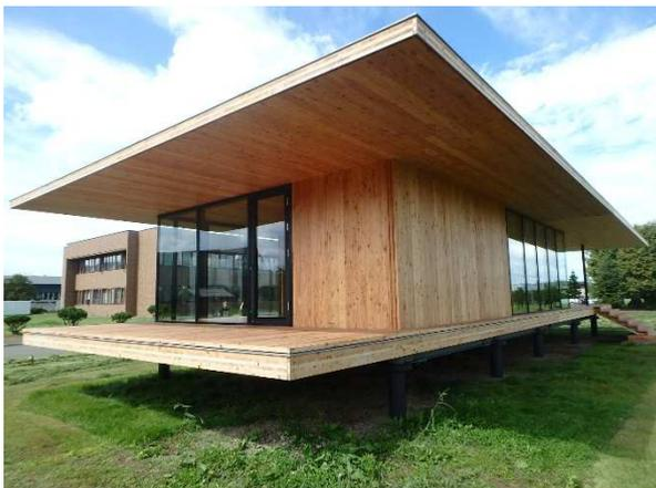
写真1:外壁・軒裏CLT使用事例
