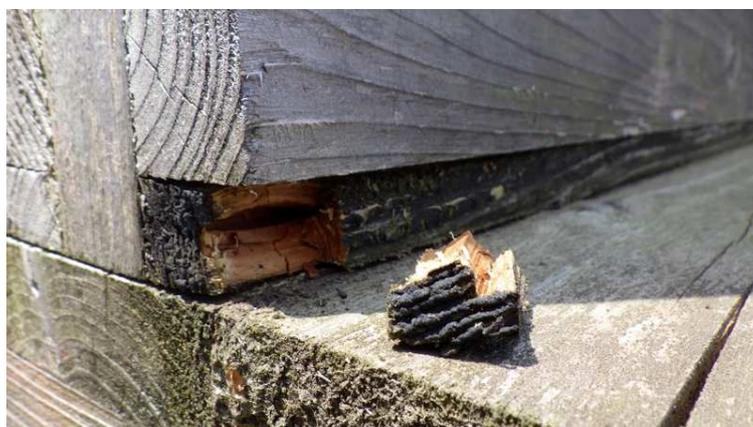
写真 15 : (設置場所:つくば／無処理材)北面と水平面の取り合い部の腐朽
