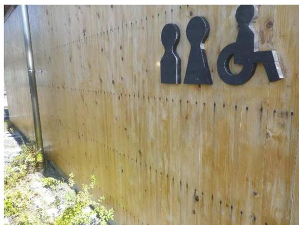
西側壁(鉄釘サビ、塗装変化)
