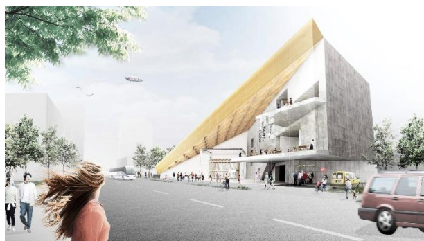
完成予想イメージパース。CLTを大架構の梁として使った最大辺長約60mの三角形の大屋根。
