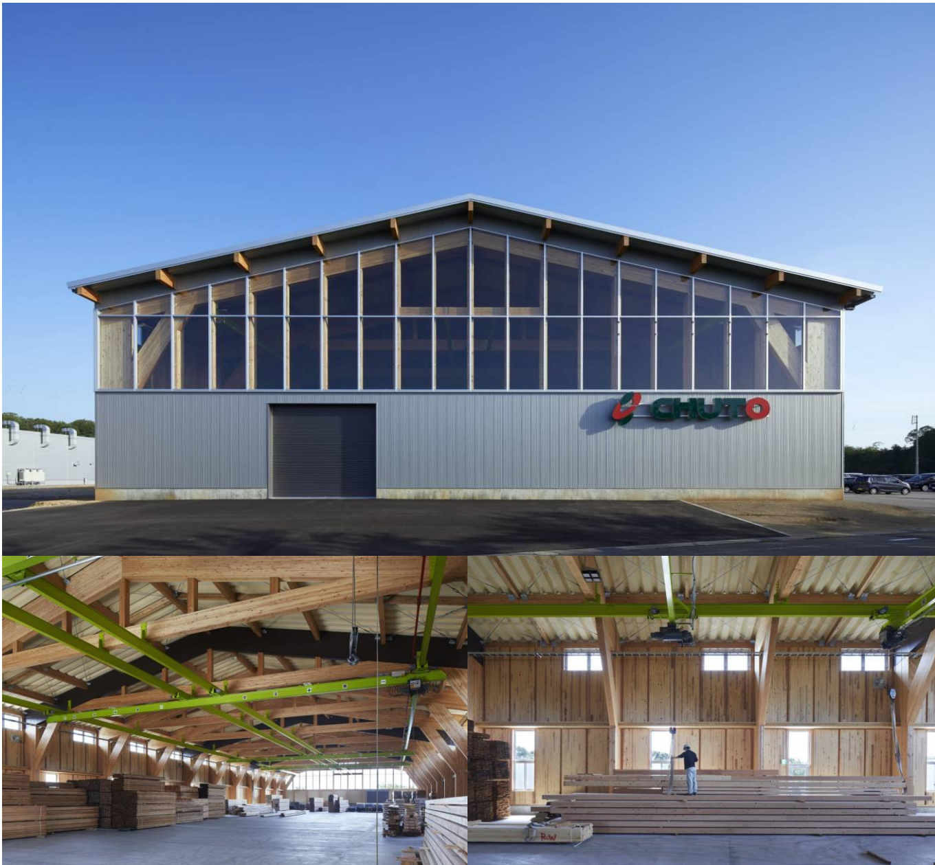
写真提供：(株)梶谷建設
