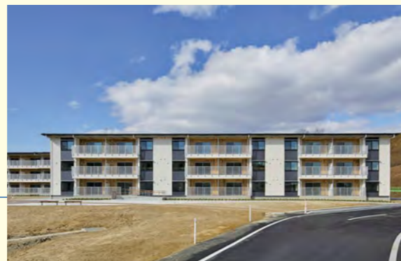
いわきCLT復興公営住宅【福島県】
