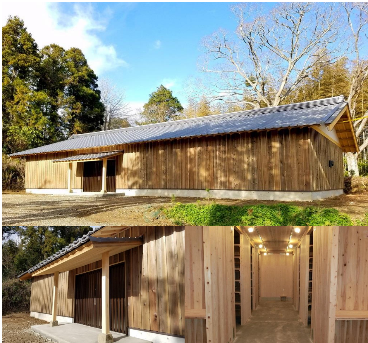
写真提供：金子建築工業(株)
