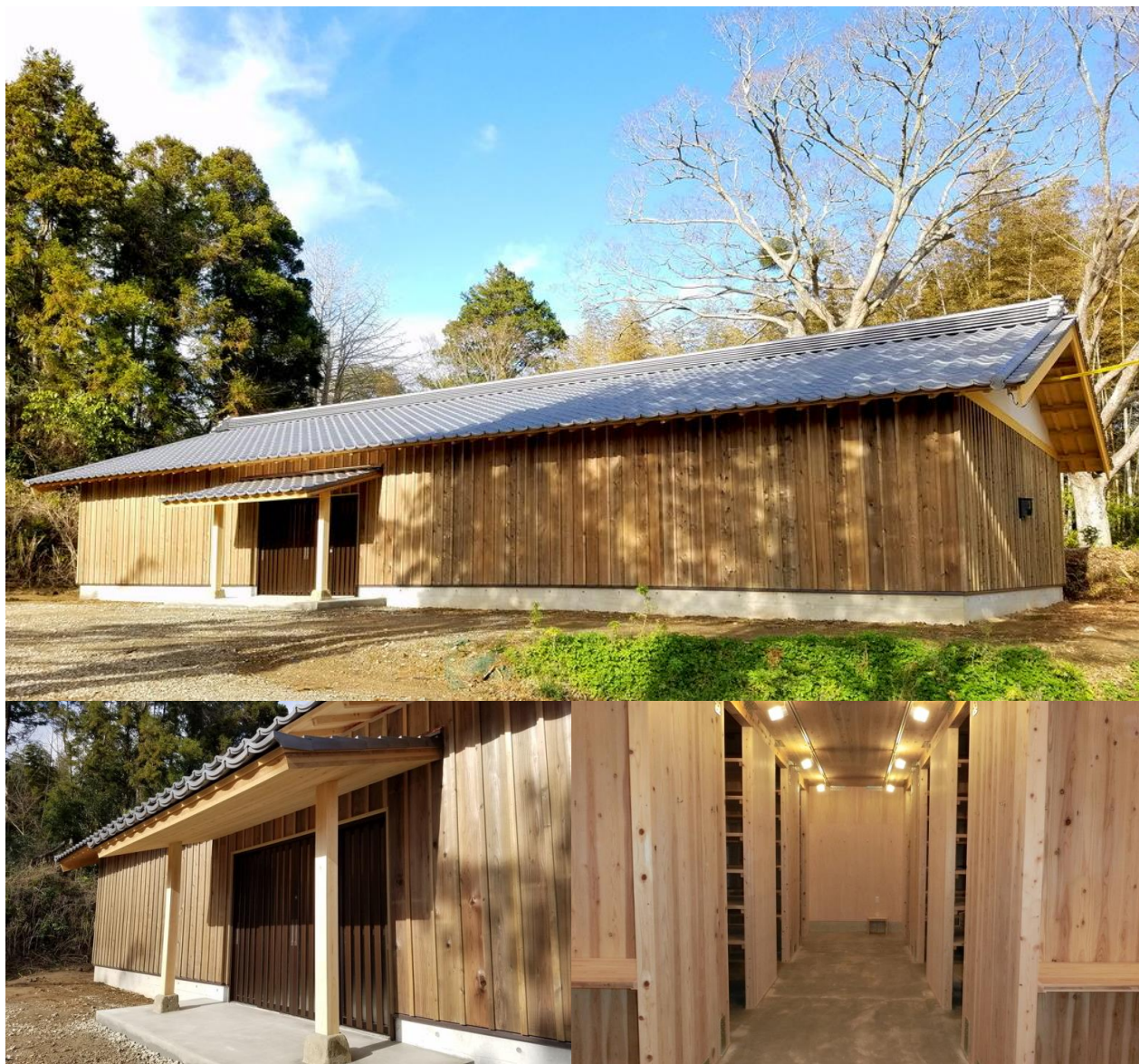
写真提供：金子建築工業(株)
