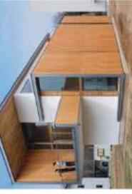
CLT（直交集成板）パネル CLT工法による実験棟
