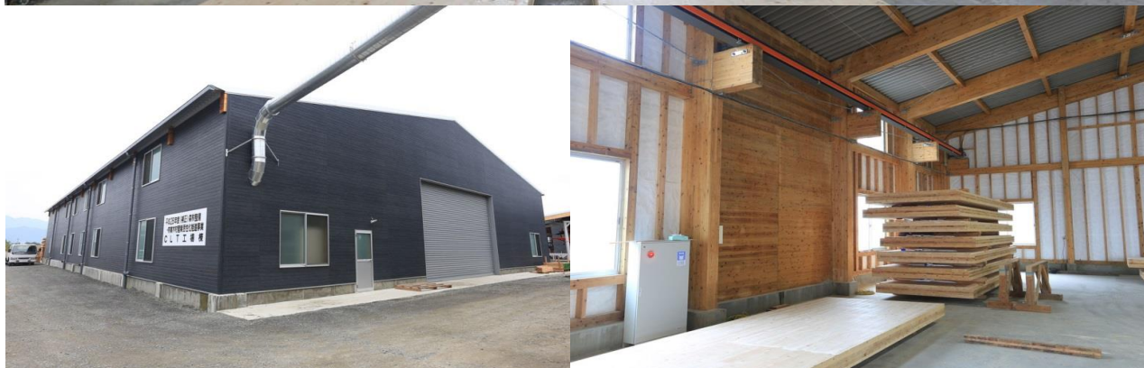
写真撮影：山佐木材(株)写真部
