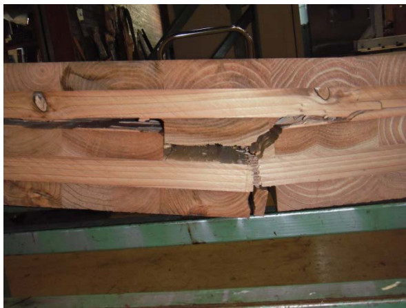
写真 5-11 FJ からの破壊例 1
