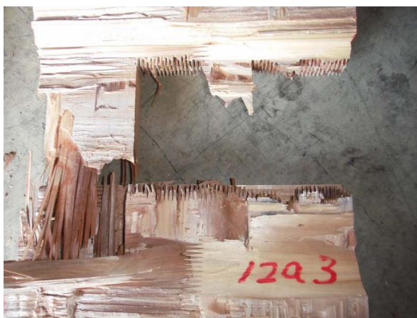
写真 5-19 No12a3 破壊状況
