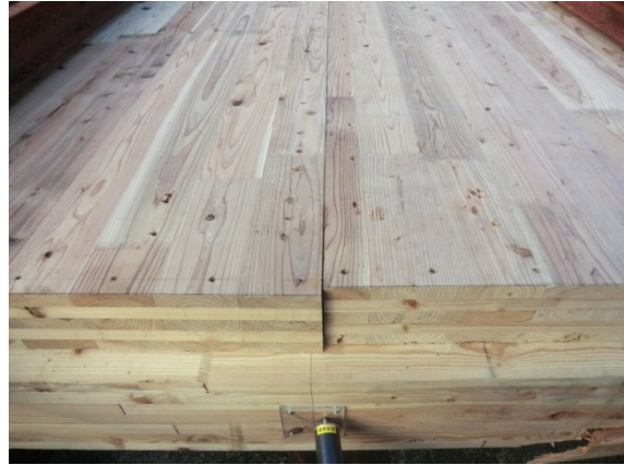
写真 2-12 パネル間接合部の変形
