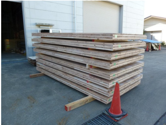
写真 2-1 搬入された CLT パネル
