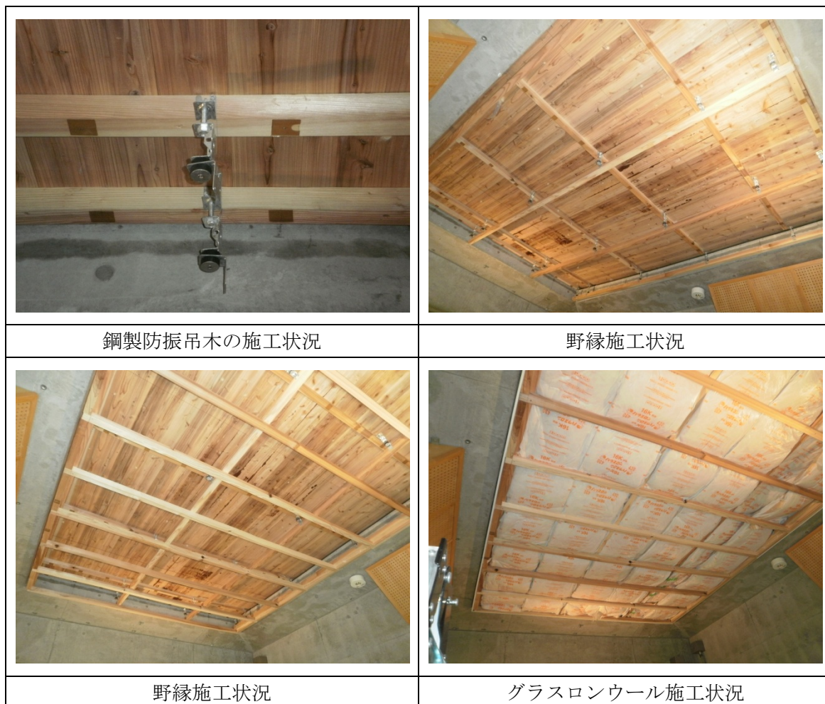
図 2-4 防振機能を備えた鋼製吊木（左上）と試験体 7 の天井施工状況
