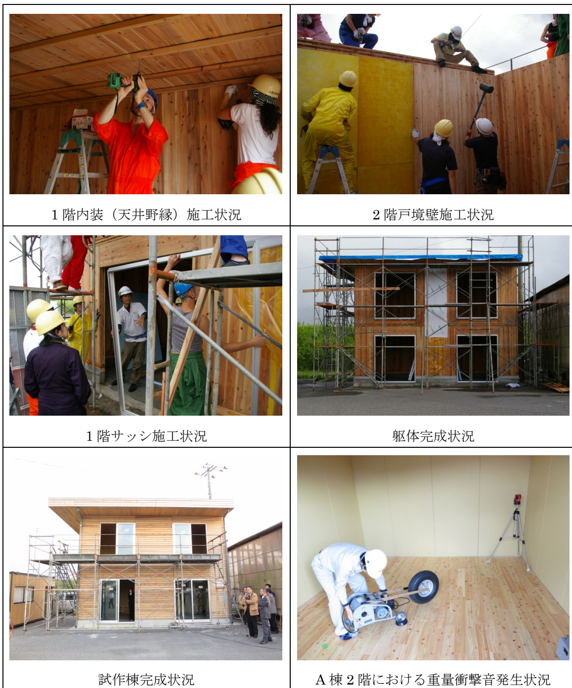
図 2-31 試作棟の施工状況および床衝撃音レベル測定試験状況
