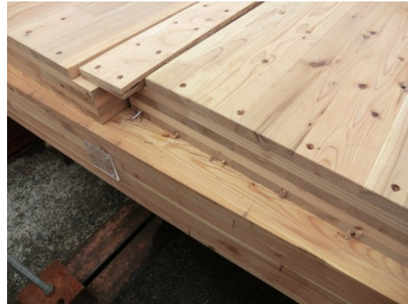
写真 2-14 西側スプライン接合部の破壊
