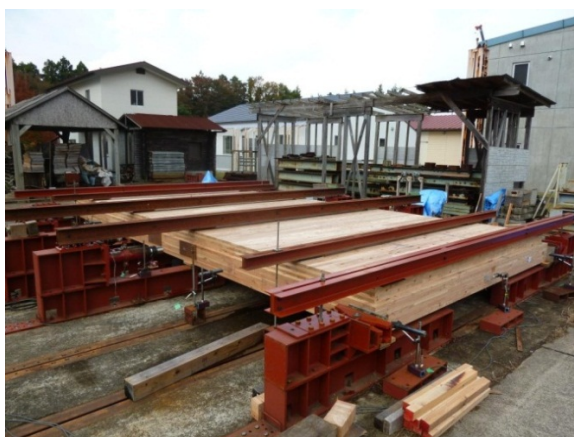
写真 2-7 浮き上がり防止鋼材の設置
