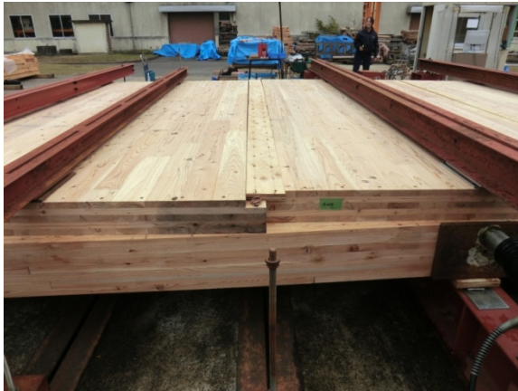
写真 2-13 東側スプライン接合部の破壊
