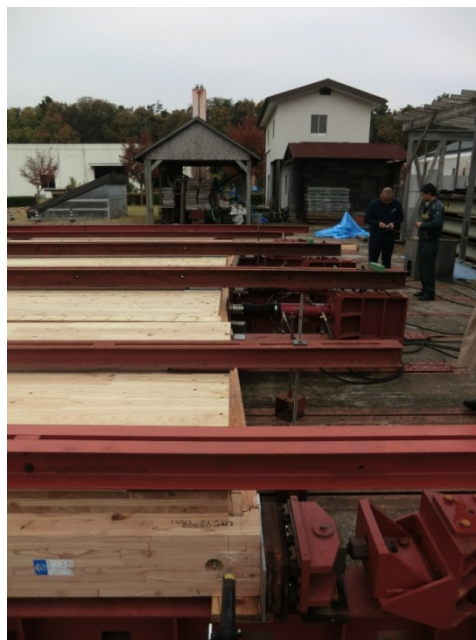
写真 2-15 梁桁材と CLT パネルの変形の違い
