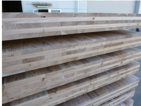
写真 2-2 CLT パネルの断面
