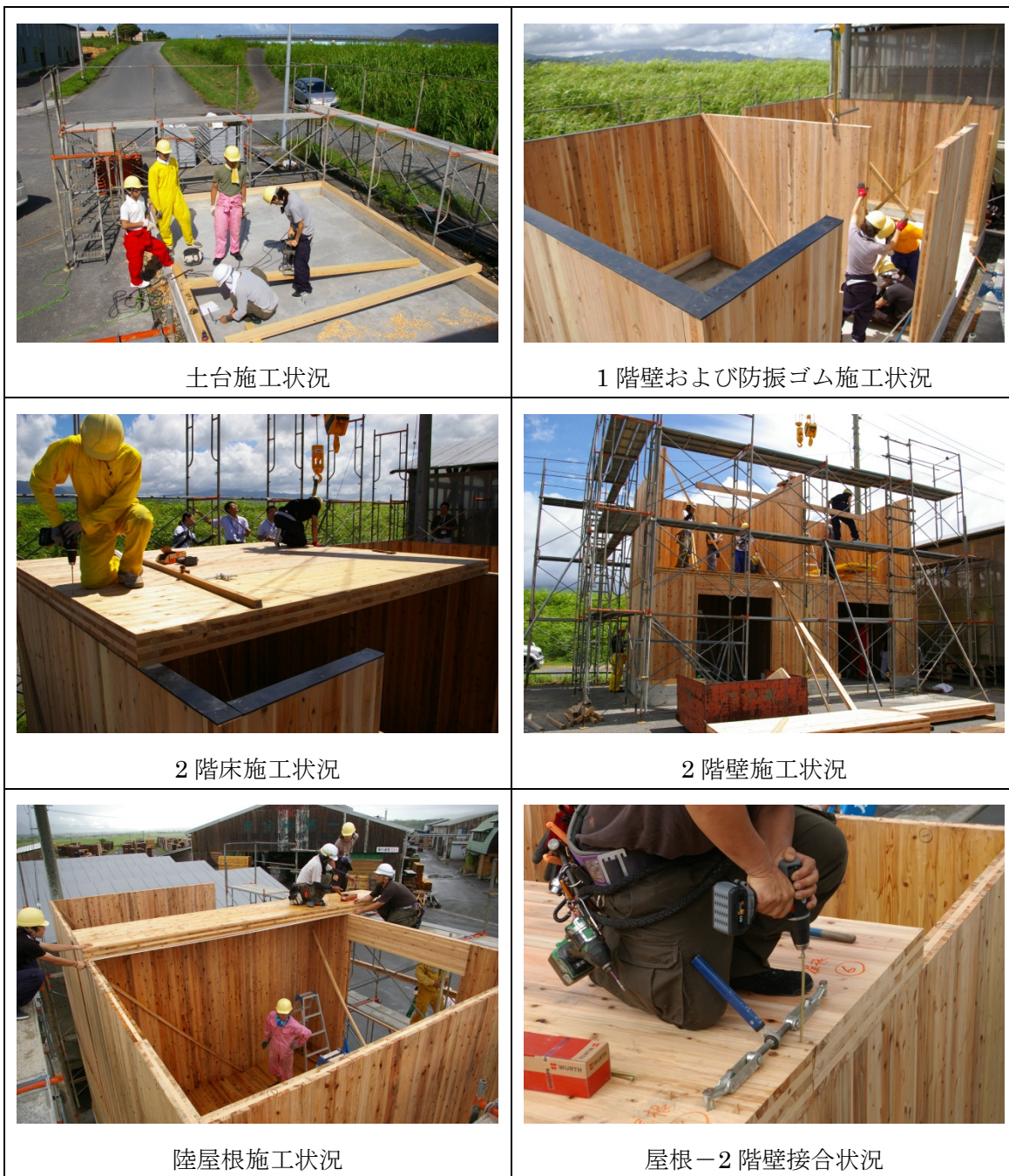
図 2-30 試作棟の施工状況
