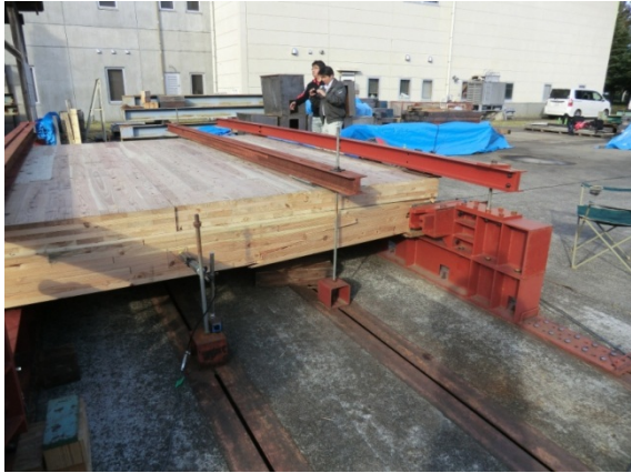
写真 2-11 南側桁材の曲げ破壊
