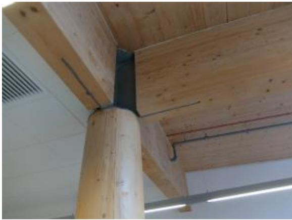
写真 6-8 集成材の柱と梁、接合金物
