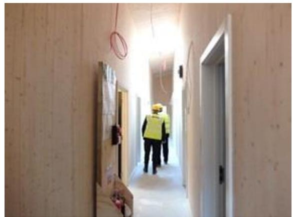
写真 3-18 居住棟の廊下部分（CLT は現し）
