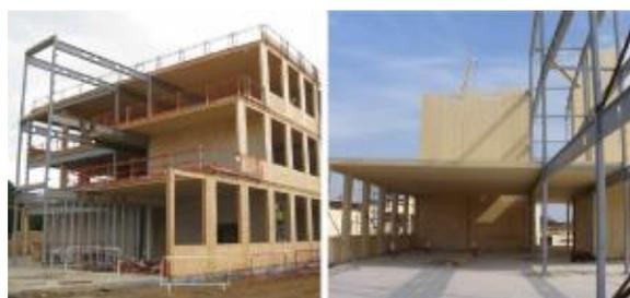
図 5-2 施工時（外周 CLT、内部鉄骨）\*5
