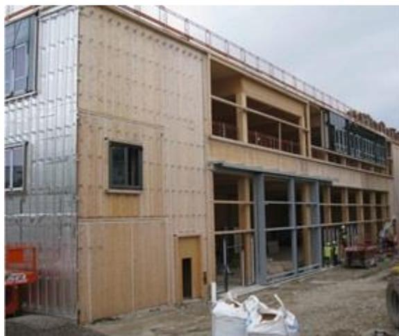
写真 5-3 建設時 (CLT, 集成材, 鉄骨が見える)
