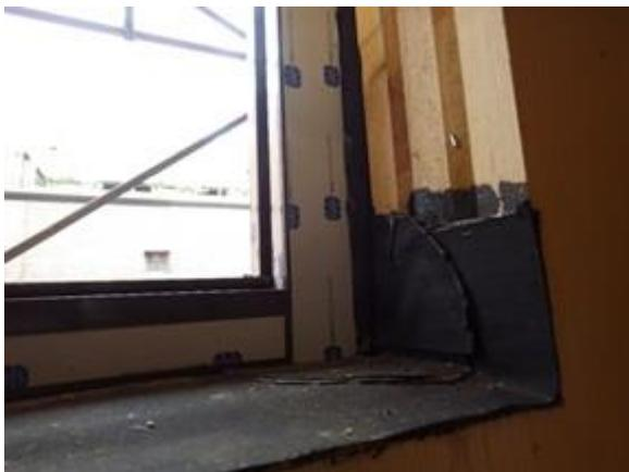
写真 9-11 開口部内側の気密施工
