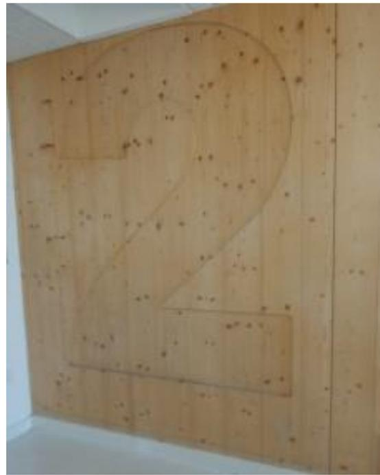
写真 6-11 階数を示すサイン(CLT に彫込み)
