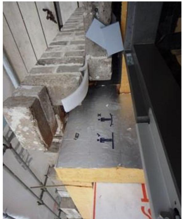
写真 9-9 外装レンガ積みの施工状況
