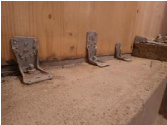
写真 9-7 CLT 壁－基礎間の接合
