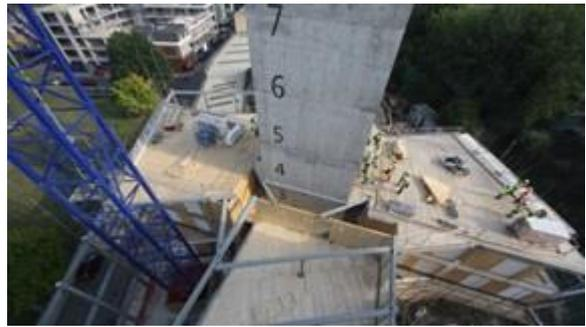
写真 1-5 RC コアと鉄骨・CLT ハイブリッド構造の施工状況\*2
