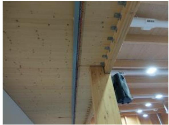
写真 7-7 露出された配線と L 型金物
