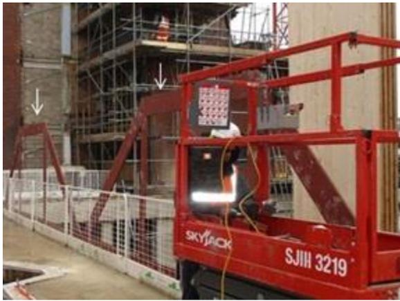
写真 9-6 CLT 壁内の鉄骨プレートトラス\*7
