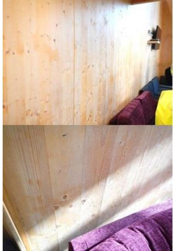
写真 3-5, 6 防火塗料が塗られた CLT の色ムラ
