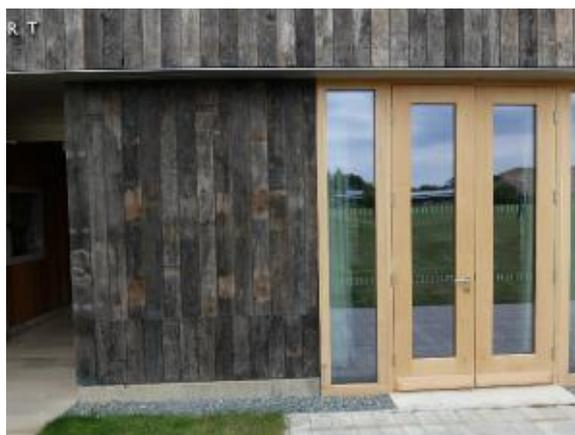
写真 10-3 外観(外装材は鉄道貨車の床材を再利用)
