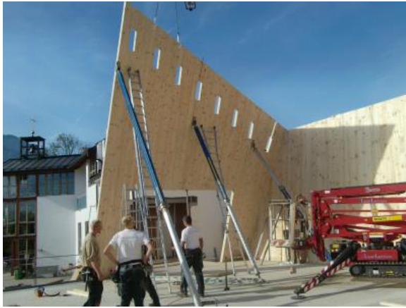
写真 10-3 施工時の CLT 壁
