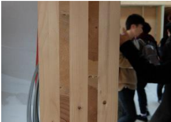
写真 4-5 CLT 壁断面 (5層7プライ、中央ラミナ厚が厚い)
