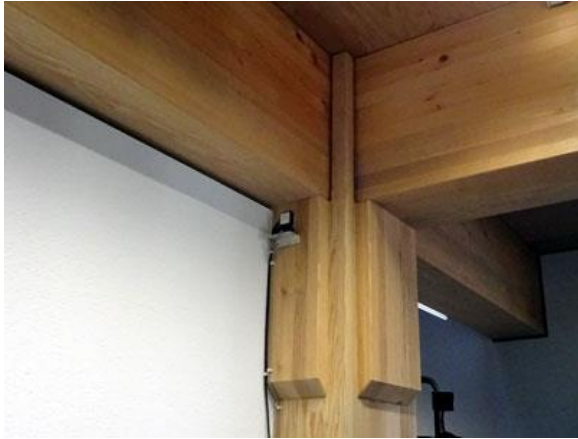
写真 5- 一部にブナのラミナを用いた集成材 (建物の中にはセンサーが多数付いており、経年変化を常時測定している)
