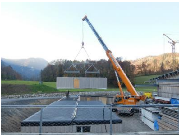
写真 3-6 プレファブユニットの吊り上げ (難民の方のシェルター用ユニット)
