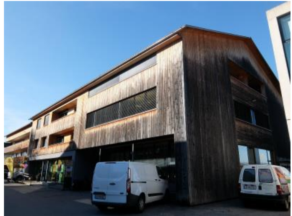
写真 15-4 経年変化による色むらの例
