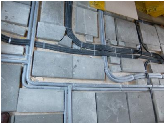
写真 3-3 プレファブユニットの床 (配線、配管とコンクリートブロック)
