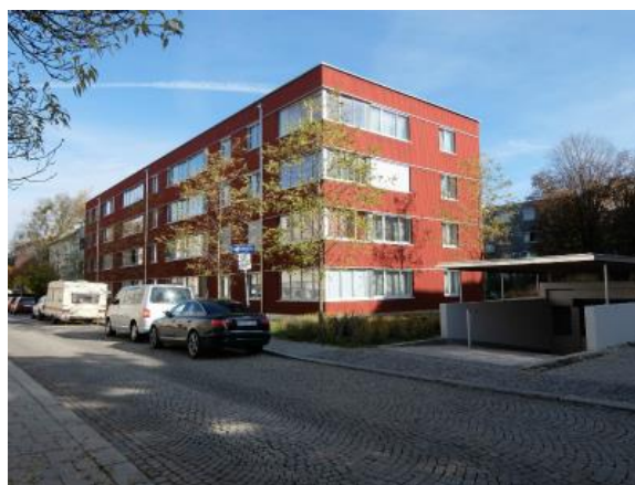
写真 15-5 バルコニーの代わりにサンルームが配置された新築棟の外観（外装材の木にはにはファールン・レッド（べんがら）が塗ってある）
