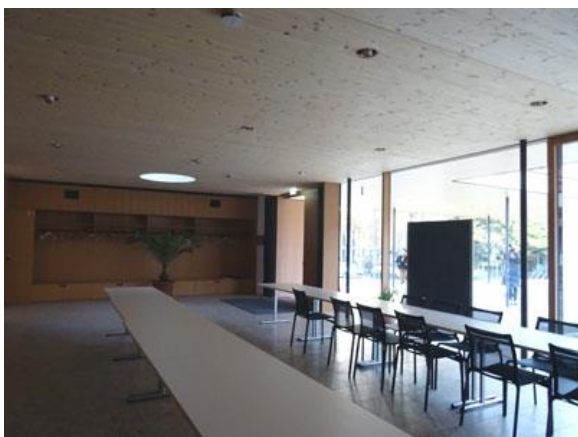
写真 14-6 水平屋根の下の鉄柱は CLT を下から支えるのではなく上部から吊っている (床のパネル同士は、パネルの中心に鉄のプレートを入れてつなげている)
