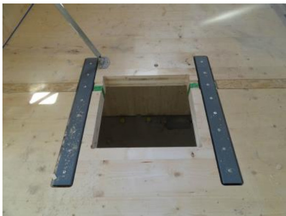
写真 1-2 床開口の補強*1
