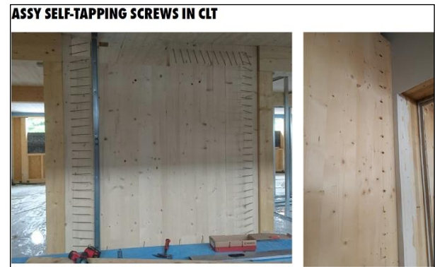
写真 16-2 [壁]軸組の開口部の中に CLT パネルを嵌める例 *4 (45° の角度で CLT から柱または梁をビスで留めていく。ビス接合は金属部分がほとんど木材に埋め込まれることによって、火事が起きた際の耐力低下も少ない)
