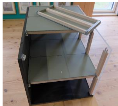
写真 1-14 LCT 1 の模型 (集成材の柱と集成材とコンクリートの複合床の構造)
