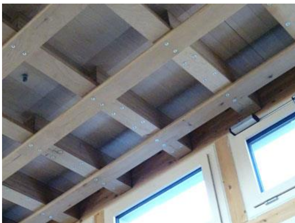
写真 5- CLT と LVL の格子梁による屋根面
