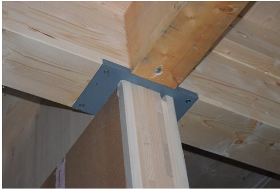
写真 4-4 CLT 壁と集成材梁取り合い (めり込み防止金物)
