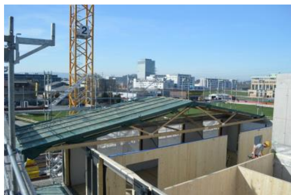
写真 1-4 トラスで組んだ仮設の屋根*1 (週末の天気が雨の時の金曜日などに設置)
