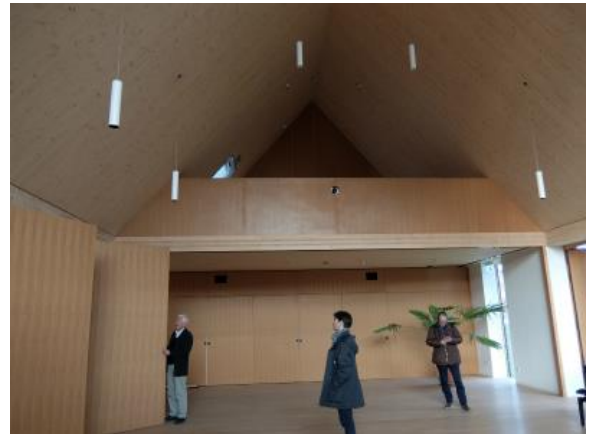
写真 14-7 右側は木製の間仕切り壁
