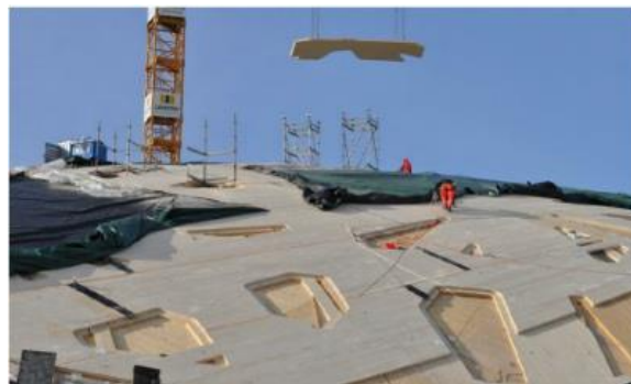
写真 5-7-1 シェルの施工の様子*2 (型枠上にプレカットした CLT パネルを敷設)
