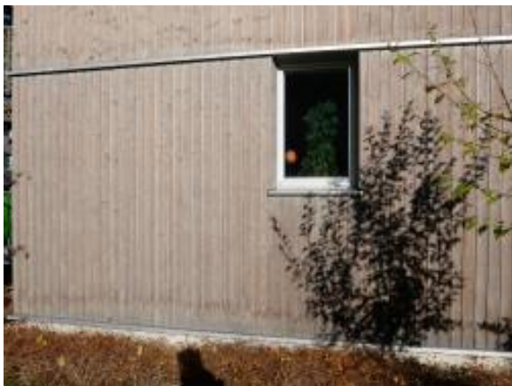
写真 15-3 スプルースの外装 (経年変化による色むらを極力防ぐため、予め変化後の風合いとなる塗料 (ADLER 社 (オーストリア))
