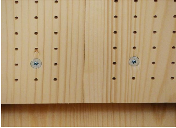
写真 12-4 吸音パネルを留め付けるビス
