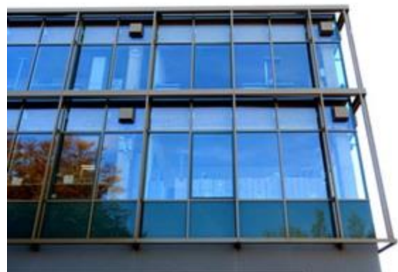
写真5- 外観 (4つ見える箱型の部分がプレストレスを調整する部分)
