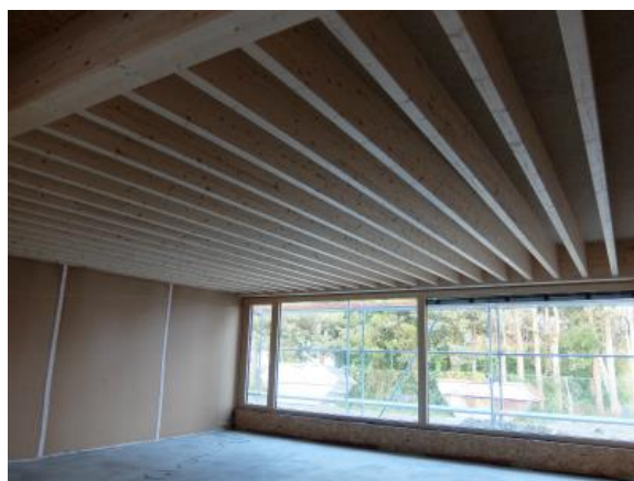
写真 4-3 教室天井の集成材梁
