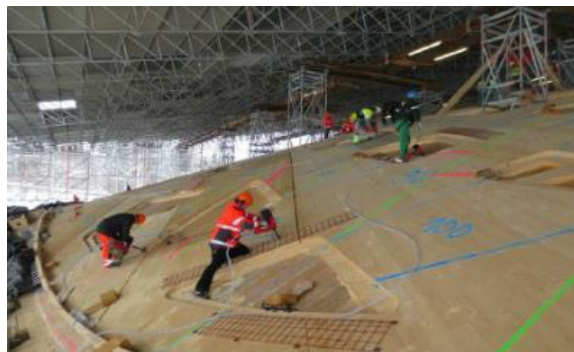
写真 5-7-2 CLT パネルをビス止めにより一体化*2
