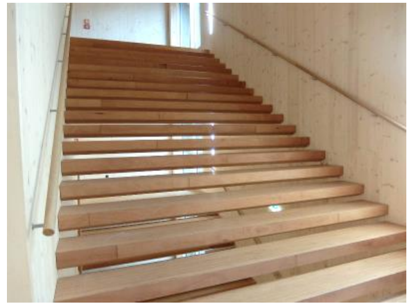
写真 12-3 階段 (CLTの壁にLVLの階段を接合。接合部分はSherpa社の金物で外からは見えないようになっている)
