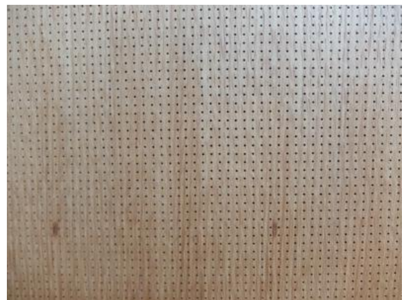
写真 14-8 木製間仕切り壁拡大 (CLT や木材ばかりの空間だと音が反響する。吸音性を持たせるため、材料に小さな穴を開けている)
