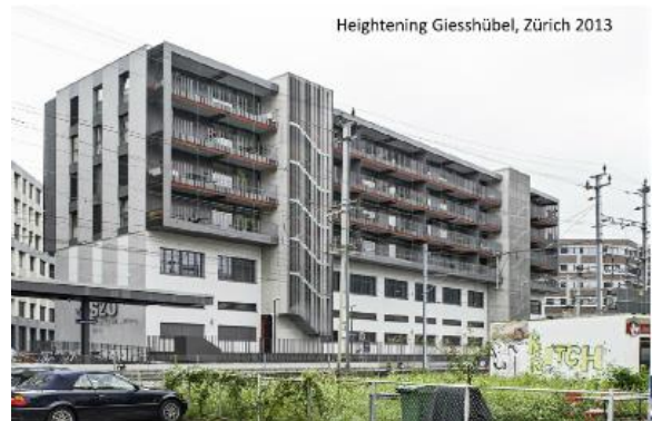
写真 5-5-5 上4層を木造で増築した例*2
