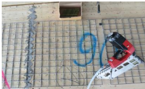
写真 5-7-3 ビスの施工に用いたテンプレート*2 (必要なビスの本数・密度に応じたテンプレートを用意し、施工ミスを防止)
