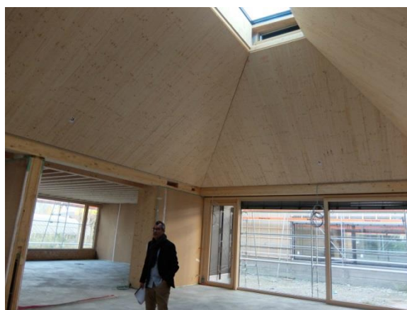
写真 4-2 屋根部分の CLT
