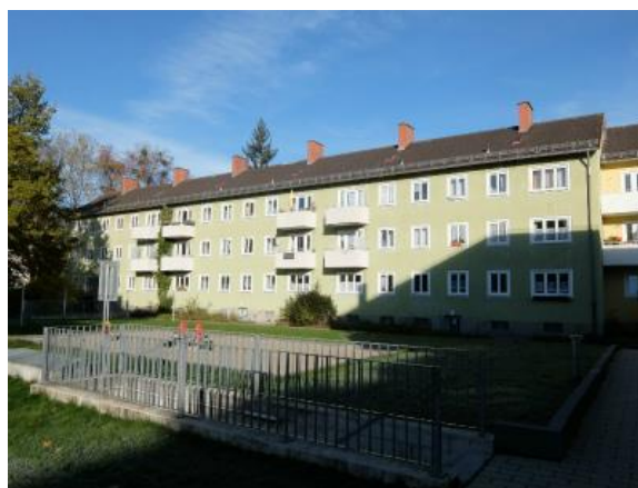
写真 15-2 未改修の既存建物（外壁塗装の補修のみ）
