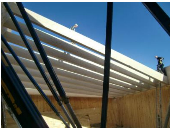
写真 10-4 施工時の集成材の梁
