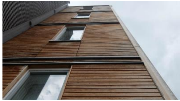
写真 8-3 階の境目の鉄製のファイヤーストップ（他階への延焼を防ぐ）
