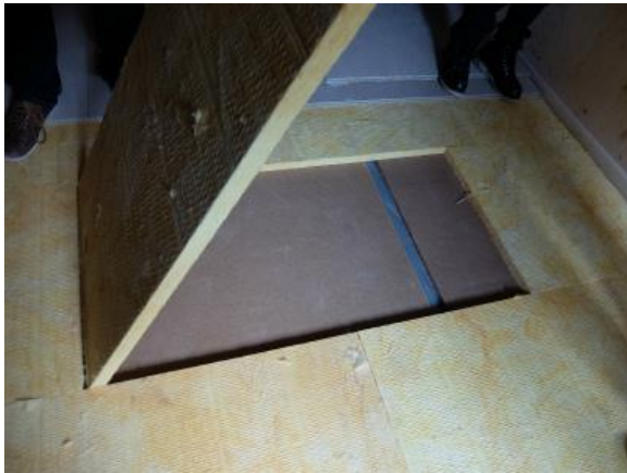
写真 3-4 プレファブユニットの床 (コンクリートブロック、配線敷き込み+パネル+吸音材[ミネラルウール]+パネル)
