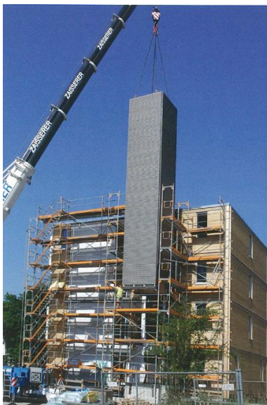
写真 8-2 エレベーターシャフト施工時 *3
