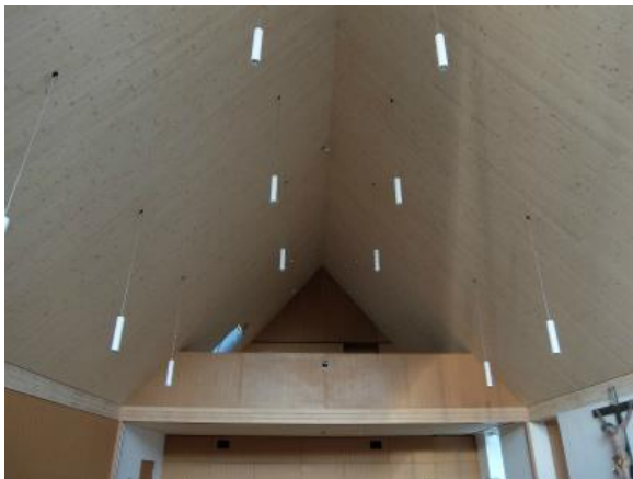
写真 14-5 三角屋根 (CLT は水平屋根の CLT に欠き込みを作り載せている)
