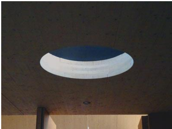
写真 14-4 水平屋根 CLT に開けられた天窗 (296mm 厚 5層7プライ)
