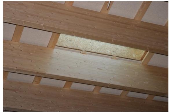
写真 4-7 16mスパンの集成材梁と母屋の収まり
