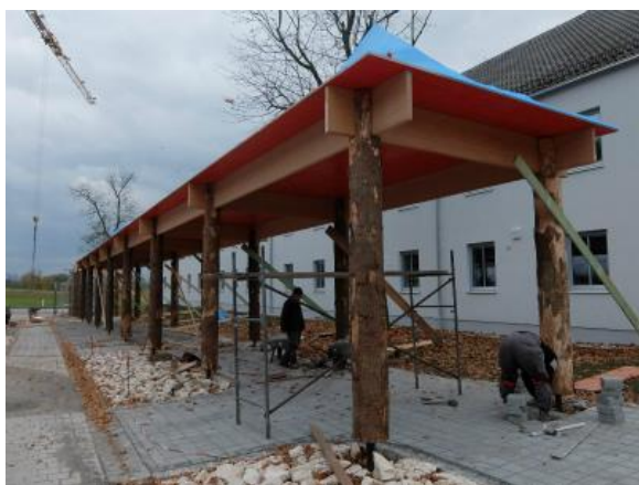
写真 8-5 近くに建設中だった自転車置き場 (丸太の柱に、LVL の梁)
