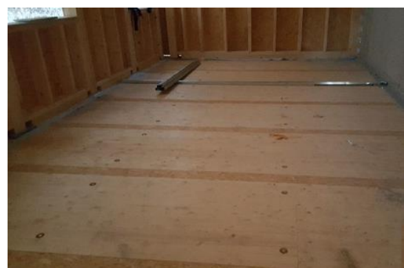
写真 16-3 [床]CLT 端部の凸の字の部分に OSB を挟んでパネル同士をビスで留めつけたスプライン接合の例 *3
