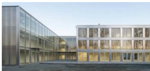
写真 1-5~8 学校建築の施工時、竣工後*1
