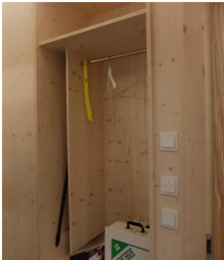
写真 12-7 収納棚（造作用の薄い3層ボードを利用）
