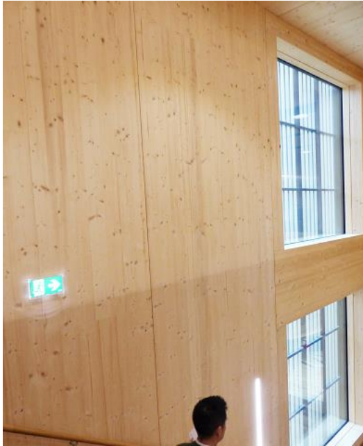
写真 12-2 壁内観 (1枚のCLTパネルが建物の1階から3階まで通っている)
