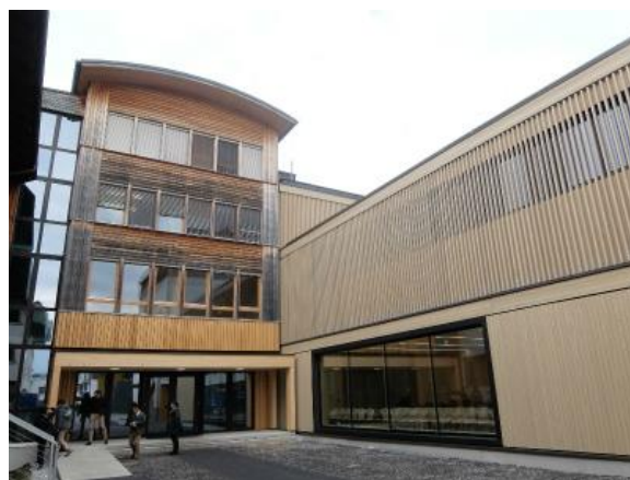
写真 12-1 外観 (右側が増築部分)
