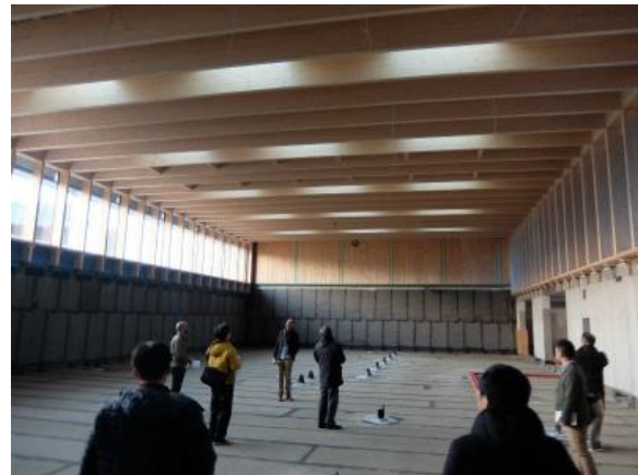
写真 4-8 体育館施工状況 (16mスパンの集成材梁)
