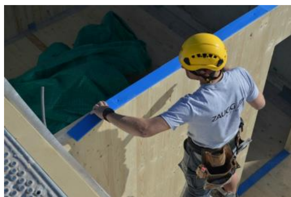
写真 1-3 ポリウレタン系防振材*1 (商品名: sylodyn、防音、防振のため壁と床の間に敷く)
