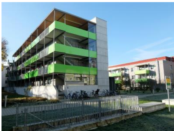
写真 15-1 Sanierung GWG 集合住宅 外観
