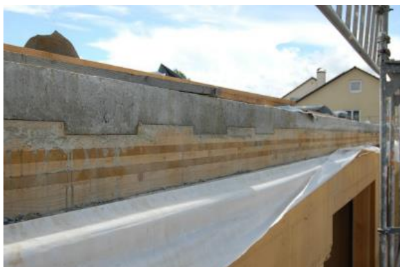
写真 1-1 CLT とコンクリートの合成床*1
