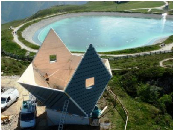
写真 1-9～11 Granat チャペル竣工後、施工時 *1
