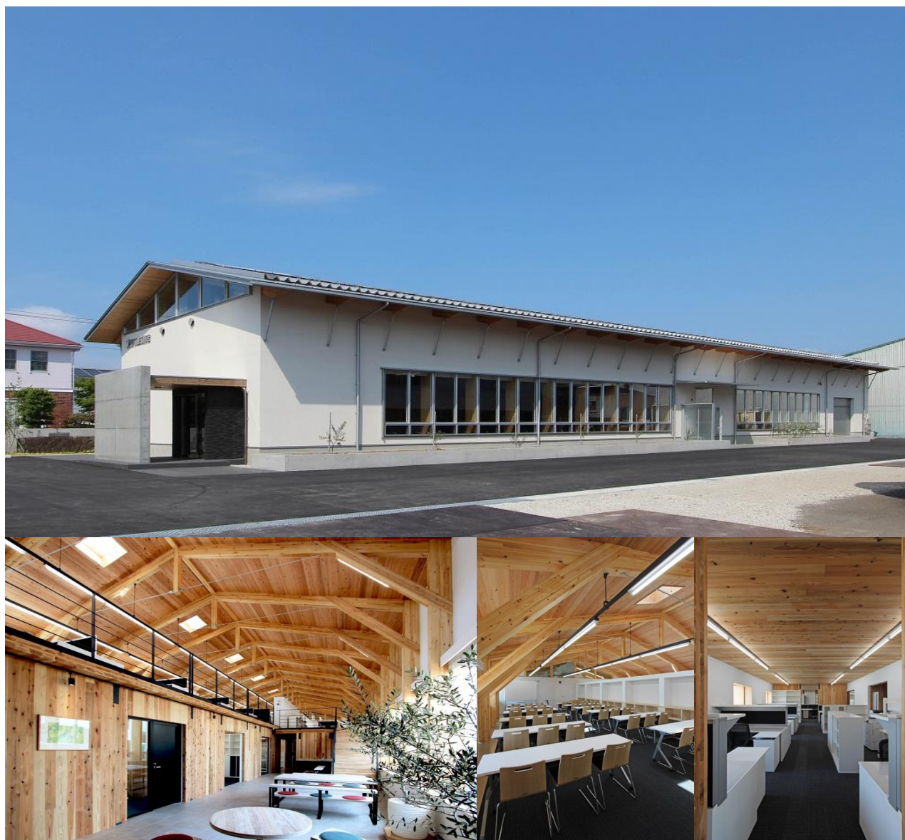
写真提供：設計事務所4D-WORKS
