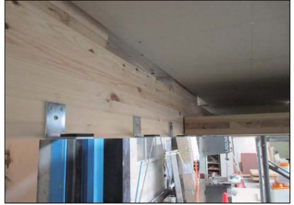
(2)L形金物の施工状況
