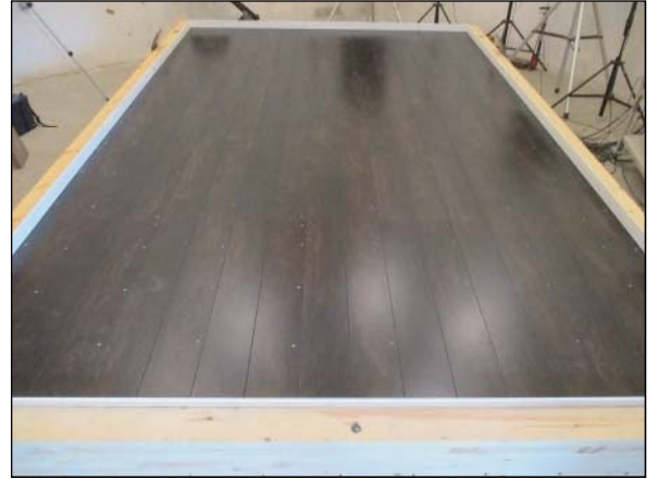
(2) 乾式二重床の全景
