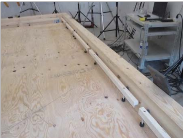
(3) 乾式二重床際根太の施工状況
