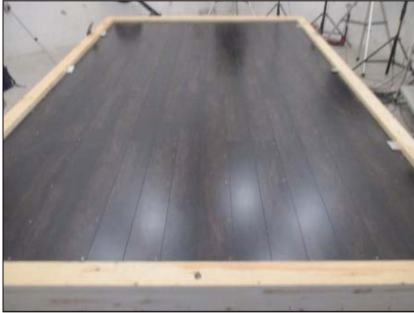
(1) 乾式二重床突板張り合板(フローリング)の施工状況
