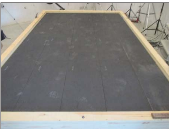
(5) 乾式二重床制振マットの施工状況
