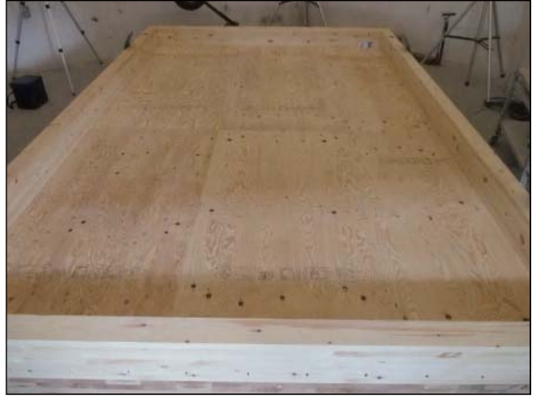
(2) 床上側構造用合板の施工状況
