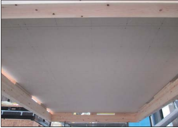
(1)床下側強化せつこうボード2層施工後の状況
