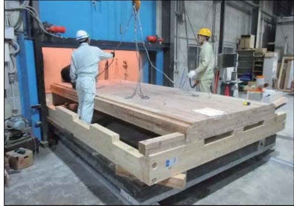
(2) 床CLT中央パネル(t=210)の設置
