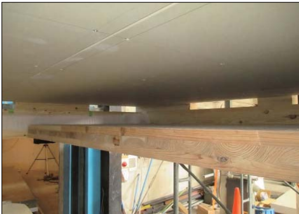
(3)天井CLTパネル(t=90)の設置状況
