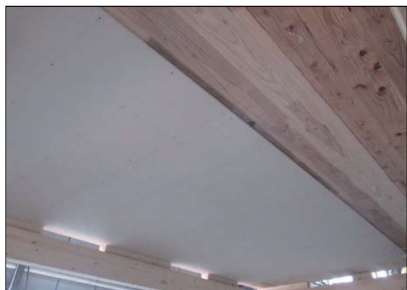
(6) 床下側強化せっこうボードの設置状況
