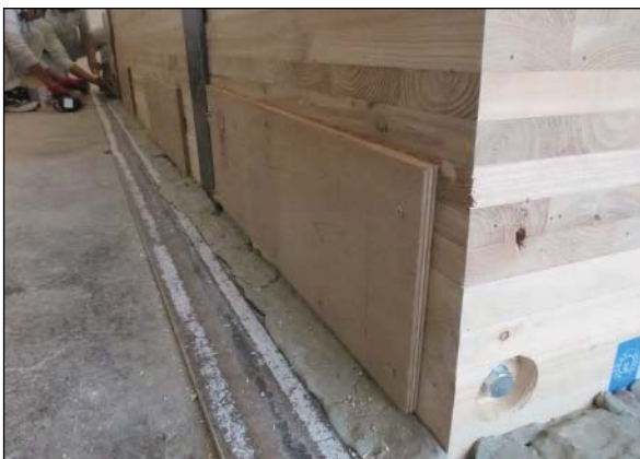
(5)空気抜きの塞ぎ状況 (空気音遮断性能の測定時)
