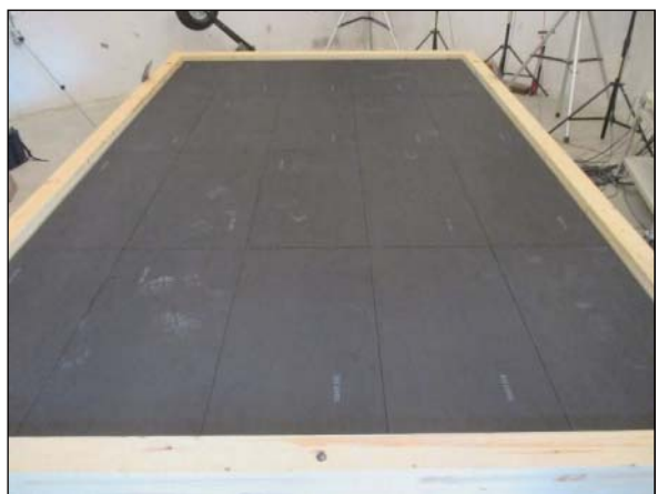
(6) 乾式二重床制振マット(2層目)の施工状況
