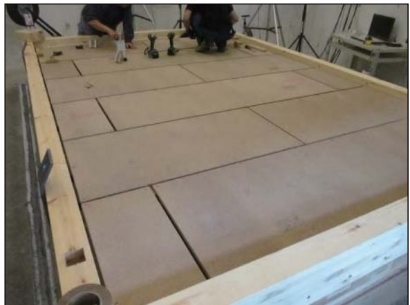
(4) 乾式二重床パーティクルボードの施工状況
