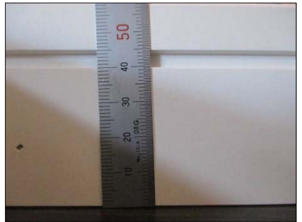
(4) 幅木の設置状況(密着)
