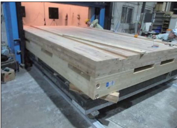
(3) 床CLT端部パネル(t=210)の設置
