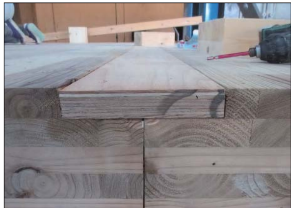
(4) 床CLTパネルのスプライン接合の状況
