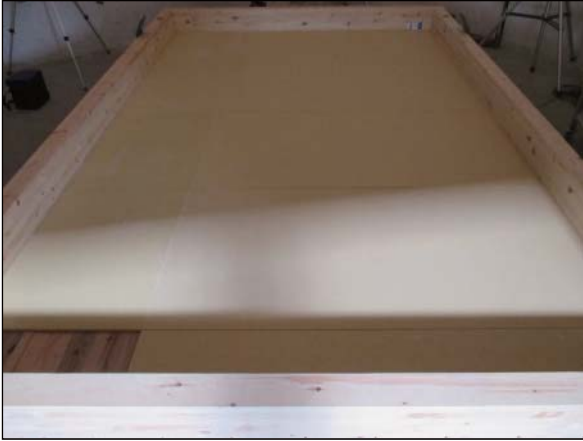
(1) 床上側せっこうボードの施工状況
