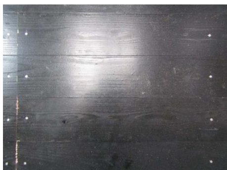
写真 2.3-9 加熱側の状況(目地 B)
