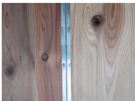
写真 2.2-18 試験前の加熱側の状況（目地 C）
