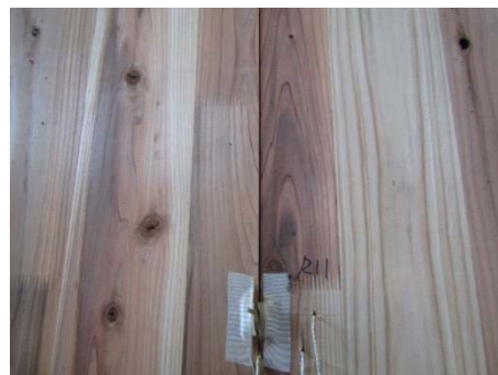
写真 2.3-14 裏面側の状況(目地 B)
