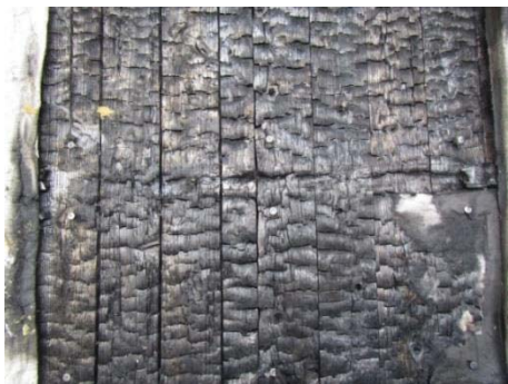
写真 2.2-66 加熱側の状況 (仕様 C 、外装材及び断熱材除去後)
