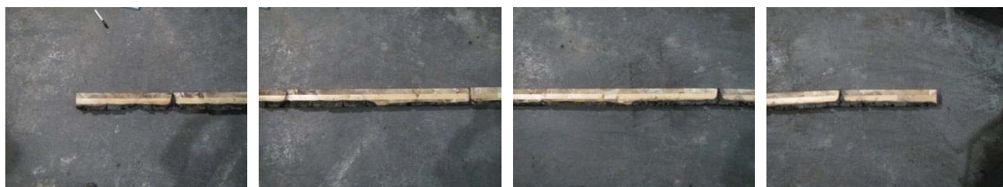
写真 2.2-102 試験後の断面状況（断面Ⅲ）
