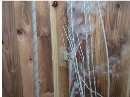
写真 2.2-75 目地 A の試験中の状況 (目地の隙間から加熱側の赤熱が見える状況)
