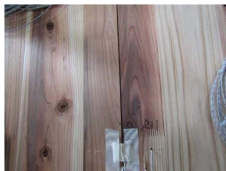
写真 2.3-10 裏面側の状況(目地 B)
