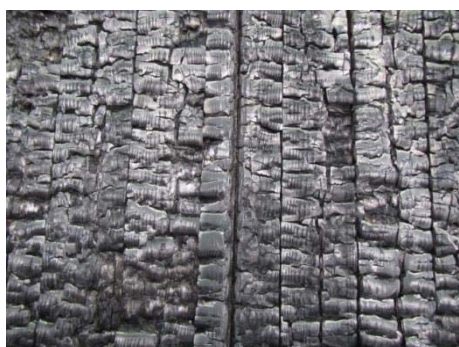
写真 2.2-42 試験後の加熱側の状況(目地 B1)
