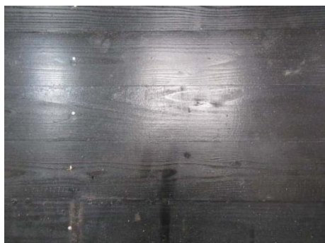
写真 2.3-7 加熱側の状況(目地 A)
