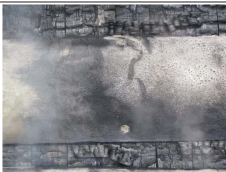
写真 2.2-46 試験後の加熱側の状況 グラスウールの留付材 ・ねじ、 \phi 3.8 \times 57 ・ツメ付き座金
