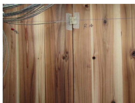
写真 2.2-61 裏面側の状況(仕様 C)
