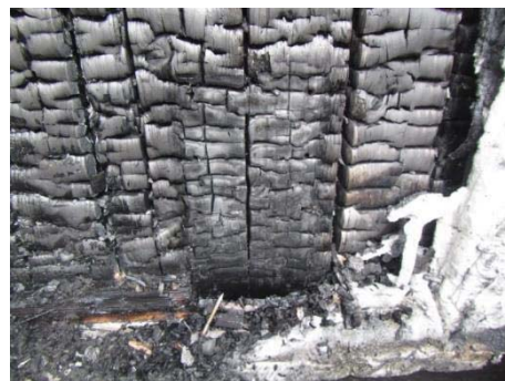
写真 2.2-95 仕様 A（金物を取外した後）
