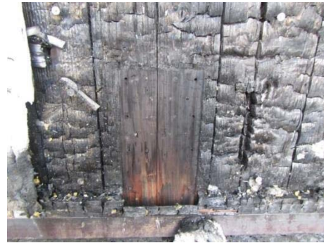
写真 2.2-71 仕様 C（金物を取外した後）
