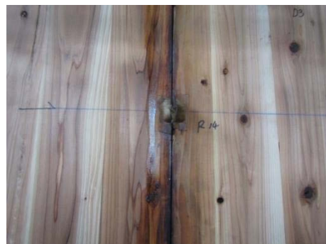
写真 2.2-67 裏面側の状況(仕様 C)
