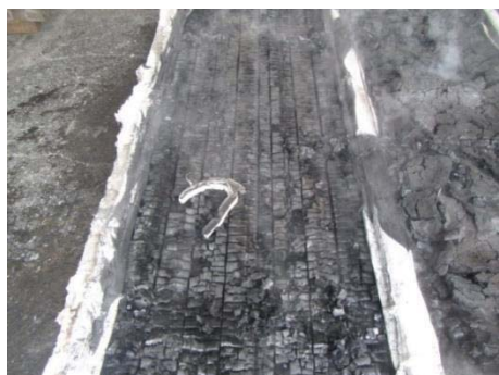
写真 2.2-88 加熱側の状況 (仕様 A, 外装材除去後)
