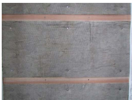
写真 2.2-56 加熱側の状況(仕様 A)
