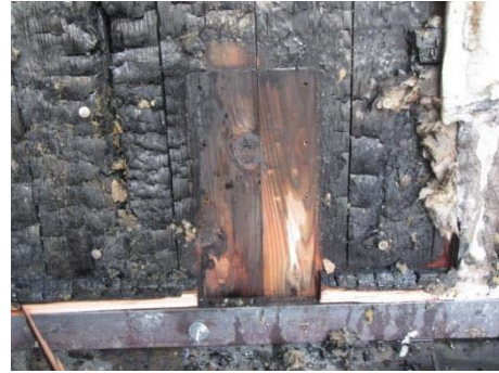
写真 2.2-69 仕様 A（金物を取外した後）
