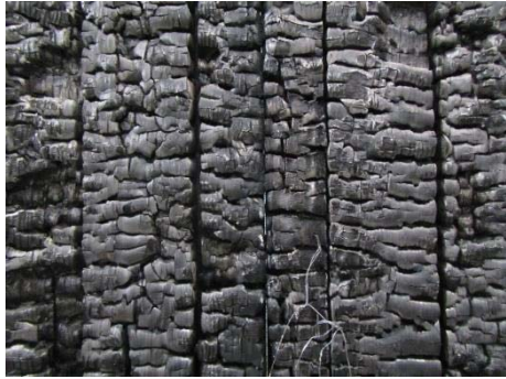
写真 2.3-27 加熱側の状況(目地 A)
