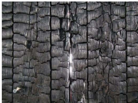
写真 2.3-11 加熱側の状況(目地 A)
