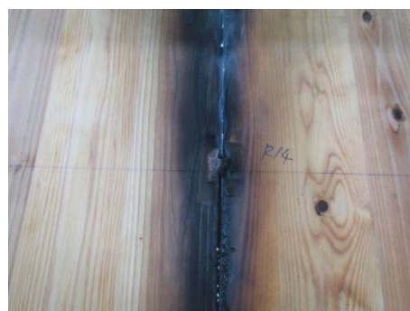
写真 2.2-93 裏面側の状況(仕様 C)
