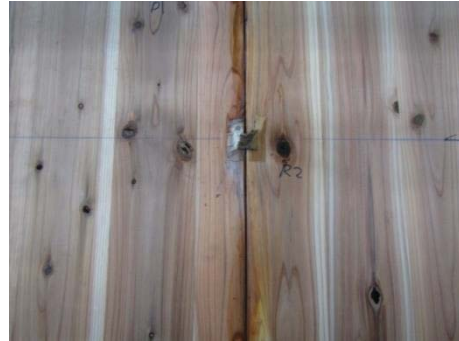
写真 2.2-63 裏面側の状況(仕様 A)
