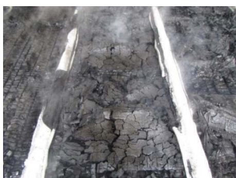
写真 2.2-90 加熱側の状況 (仕様 B, 外装材除去後)
