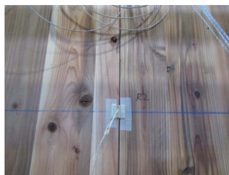
写真 2.2-83 裏面側の状況(仕様 A)
