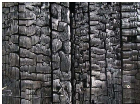
写真 2.3-13 加熱側の状況(目地 B)
