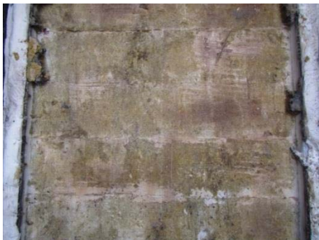
写真 2.2-64 加熱側の状況 (仕様 B 、断熱材除去後)
