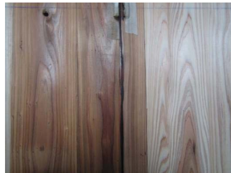
写真 2.2-25 試験後の裏面側の状況（目地 C）
