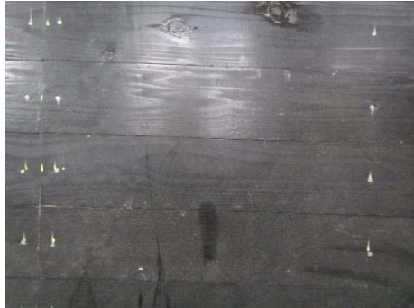
写真 2.3-23 加熱側の状況(目地 A)
