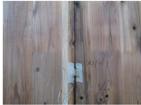
写真 2.3-30 裏面側の状況(目地 B)
