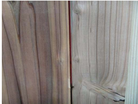
写真 2.2-50 目地 A の試験中の状況（目地の隙間から加熱側の赤熱が見える状況）
