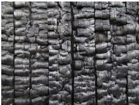
写真 2.2-22 試験後の加熱側の状況（目地 B）
