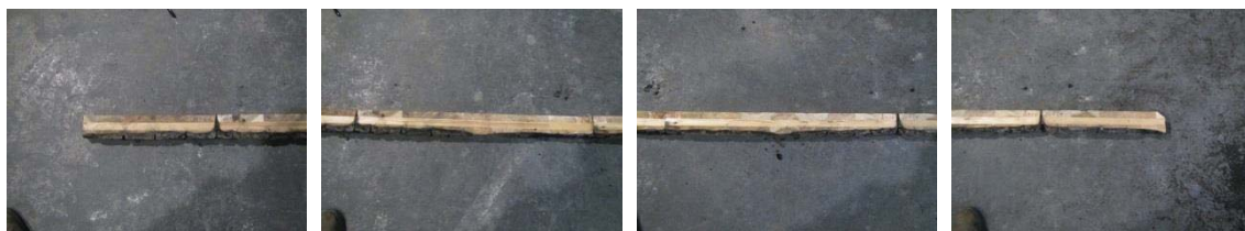
写真 2.2-101 試験後の断面状況（断面Ⅱ）
