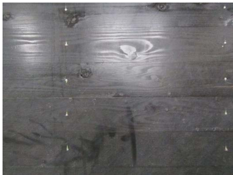
写真 2.3-25 加熱側の状況(目地 B)
