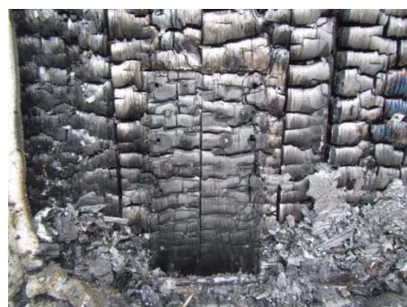
写真 2.2-99 仕様 C（金物を取外した後）
