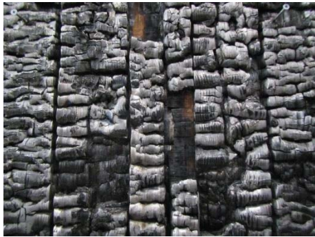
写真 2.3-29 加熱側の状況(目地 B)
