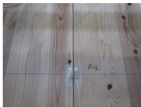
写真 2.2-87 裏面側の状況(仕様 C)
