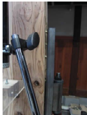
写真 3.3-3 HD のビスの引き抜け による変形角
