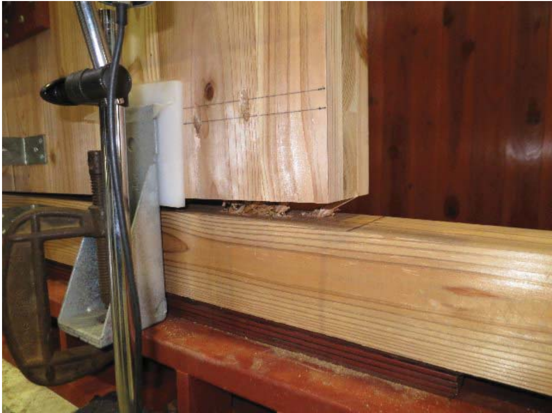
写真 3.2.2.4-47 右柱脚部浮き上がりの様子 (NB1-3)
