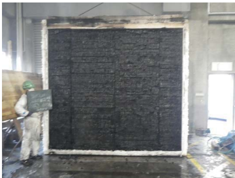
写真 3. 2. 4-38 CLT 載荷壁⑥試験体 (加熱後)
