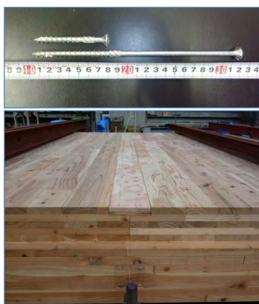
写真2 仕様②で使したビス(上) とパネル間接合部施工状況(下)
