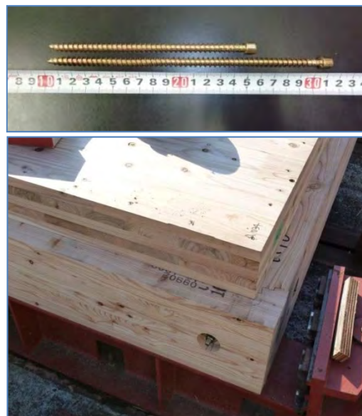
写真1 仕様①で使したビス(上) と外周部施工状況(下)
