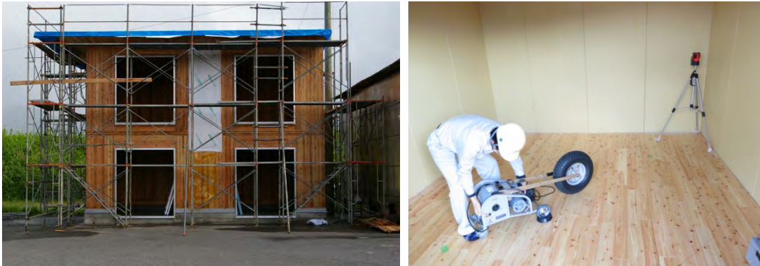
図 2-6 試作棟の施工状況および床衝撃音レベル測定試験状況
